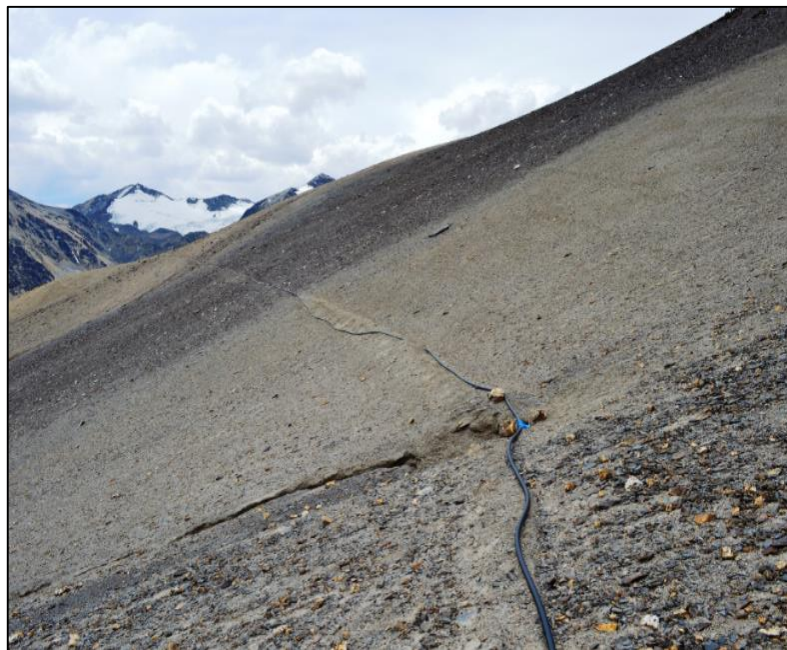
Fotografía N° 16: El campamento minero se abastece de agua mediante una tubería extendida a lo largo de 2.5 Km. aprox., desde inmediaciones de uno de los frentes glaciares del Nevado Chimbolla.
