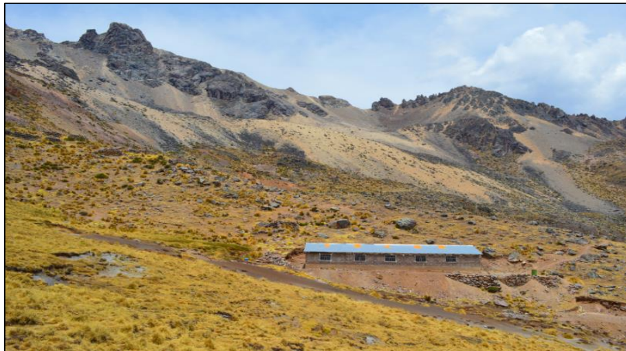
Fotografía N° 14: Labores mineras en el ámbito de la Cordillera La Raya.
