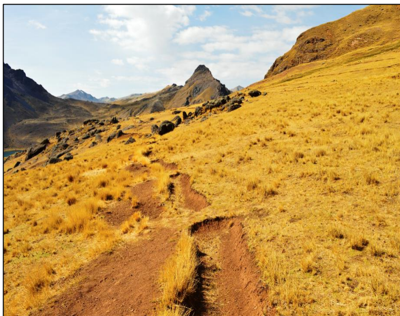
Fotografía N° 17: Se observan trabajos de excavación para zanjas de infiltración en laderas.
