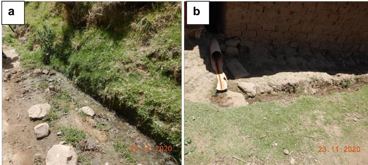
**Figura 12.** A) Vista de canal que drena las aguas residuales, producto de la ruptura de tuberías de desagüe, con coordenadas UTM (WGS 84): 817169 E, 8498303 N a 3610 m s.n.m. B) Tuberías de desagüe en pésimas condiciones, aguas vertidas sobre el terreno.
