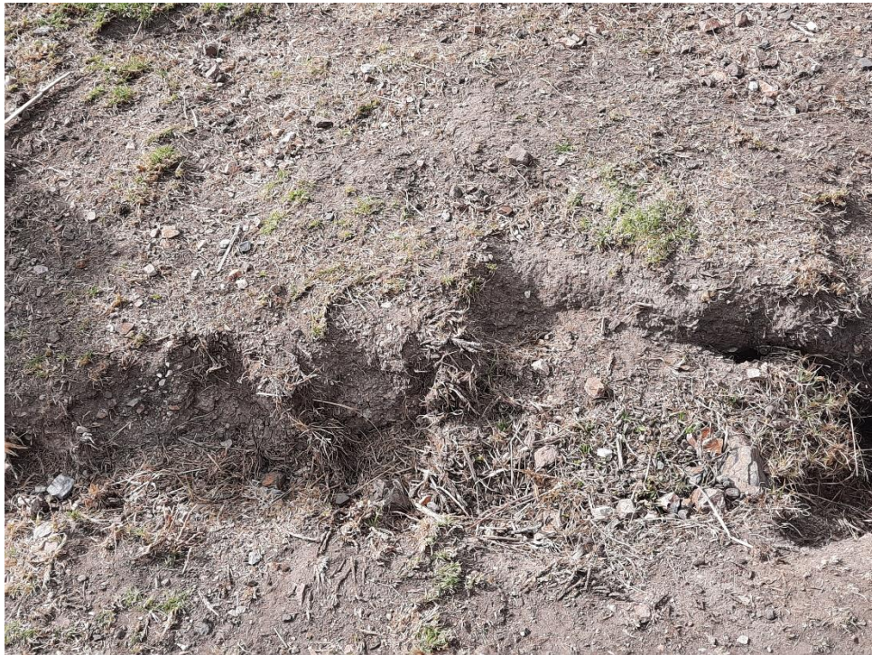
Fotografía 10. Presencia de saltos y grietas en la parte baja de Cajas.
