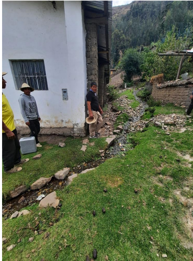
Fotografía 7. Canales de agua no revestidos sobre el pueblo de Cajas.
