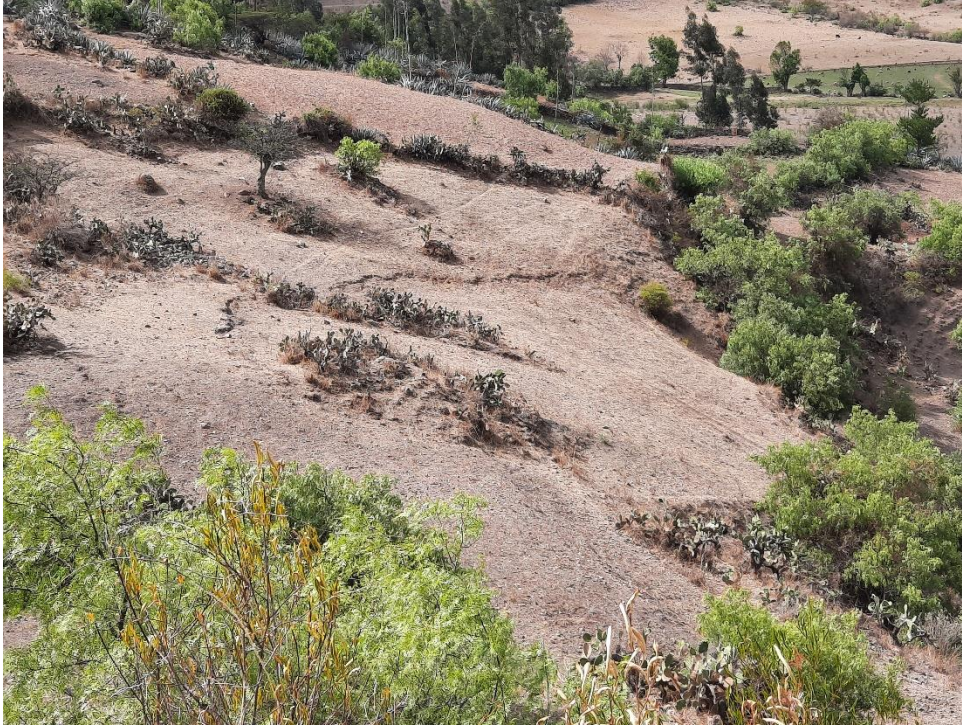
Fotografía 11. Agrietamiento circular la parte baja de Cajas.
