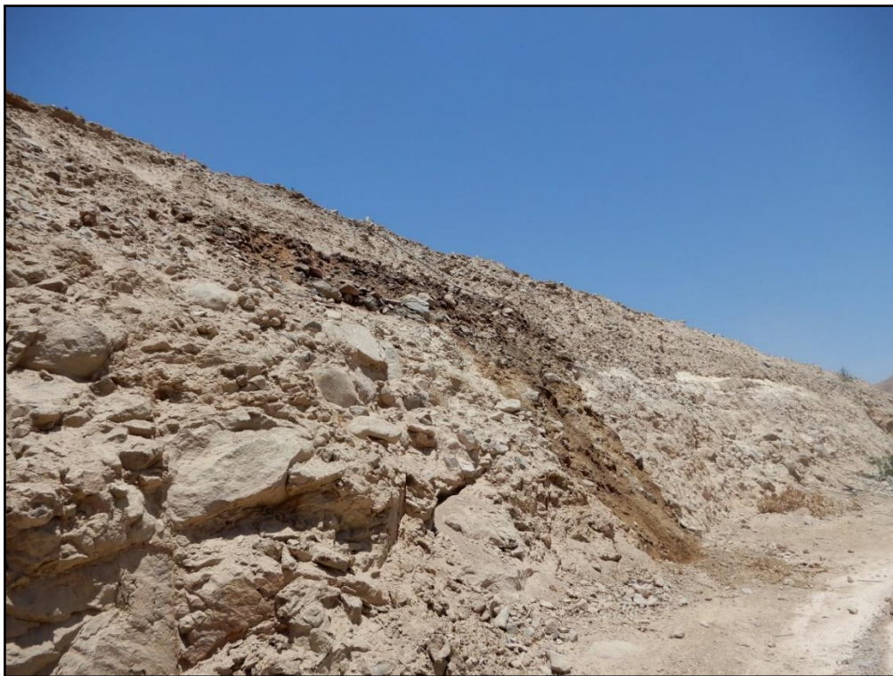
Figura 23. Surgencias de aguas en los cortes de la carretera en el sector Alto Ilabaya (coordenadas UTM E: 339254, N: 8072788).
