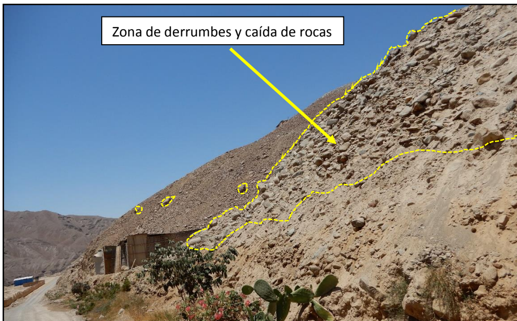
Figura 12. Caída de rocas en el sector Alto Ilabaya (coordenadas UTM E: 339262, N: 8072784).
