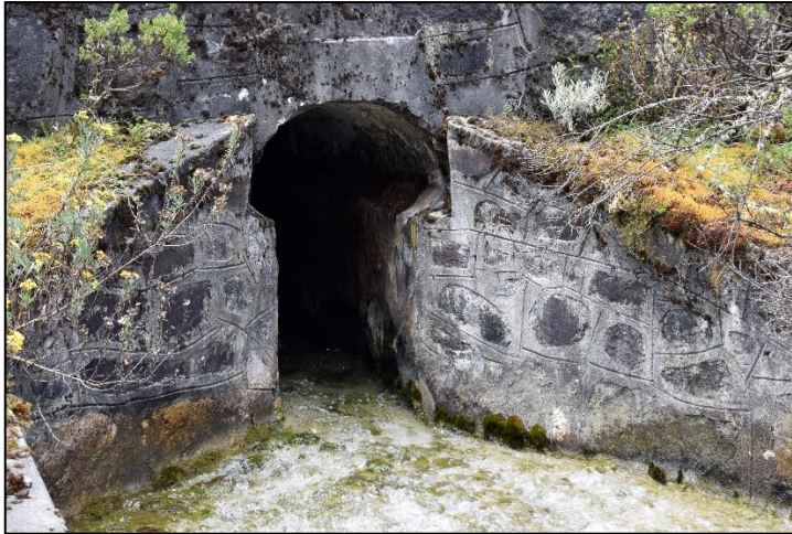
Fotografía N.º 10: Aletas del Canal de Aducción.
