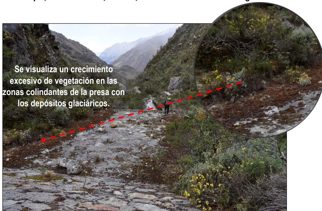
Fotografía N.º 08: Dique de seguridad: se visualiza deterioro del revestimiento – cara anterior del dique, identificándose, además, el crecimiento excesivo de vegetación.
