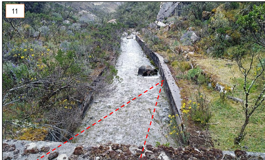
Fotografías N.º 11 y 12: Canal de Salida.
