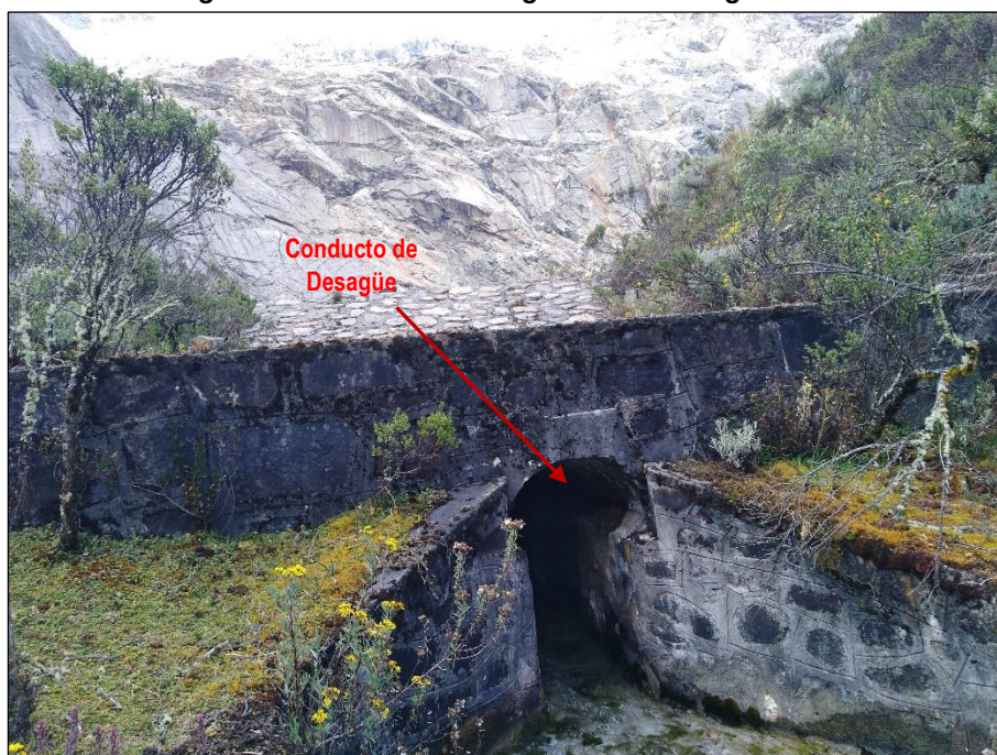
Fotografía N.º 07: Obras de Seguridad de la Laguna Arteza
