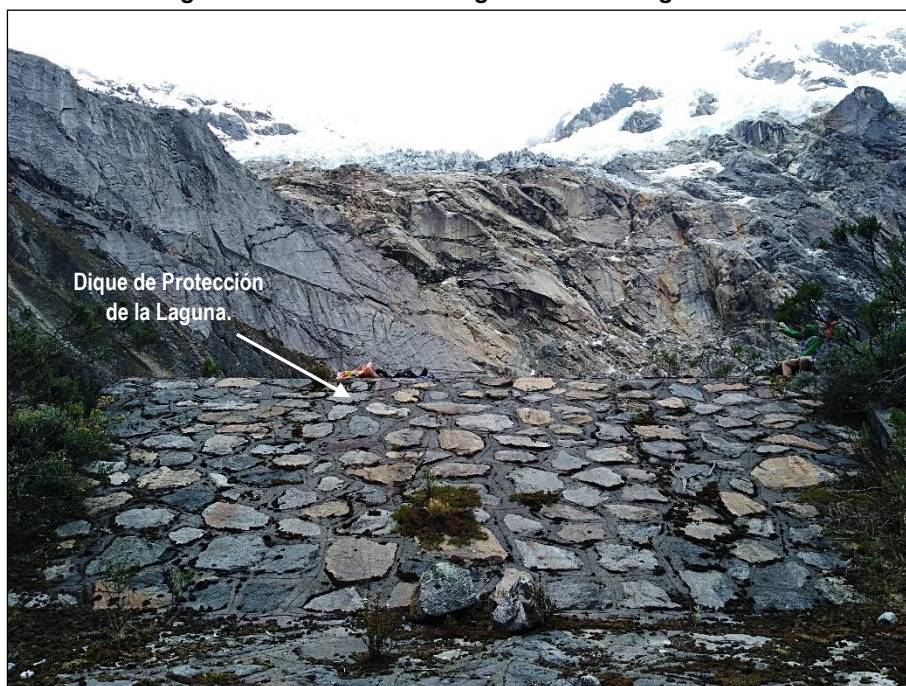
Fotografía N.° 06: Obras de Seguridad de la Laguna Arteza
