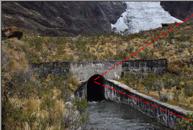
Fotografía N° 8. Conducto cubierto – Laguna Pucacocha
