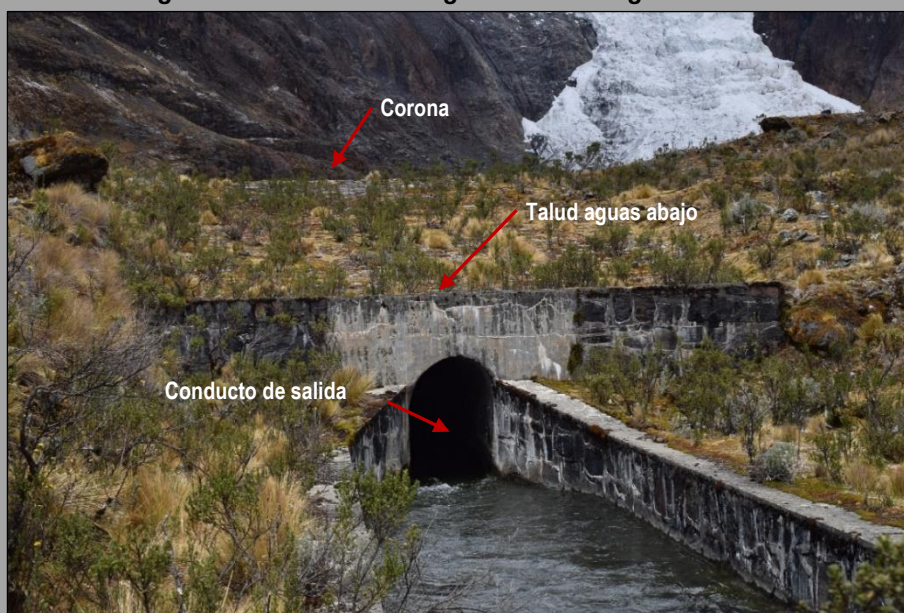
Fotografía N° 05. Obras de Seguridad de la Laguna Pucacocha
