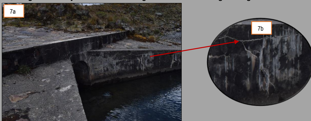
Fotografía N° 7 a y 7b. Transición de Ingreso al Canal de Desagüe – Laguna Pucacocha
