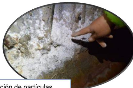
Se visualiza la acumulación de partículas blanquecinas y oxido en paredes del conducto.
