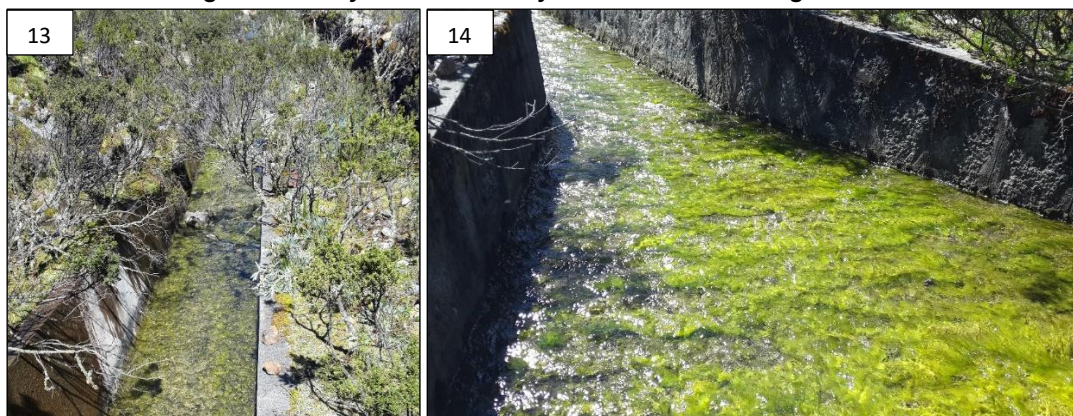
Fotografía N.º 13 y 14. Transición y Canal de Salida – Laguna Paccharuri
