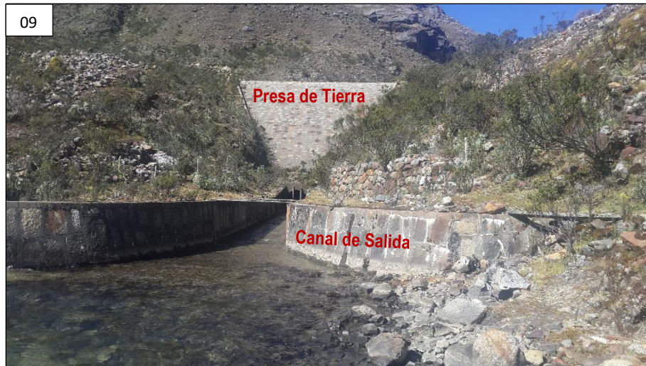
Fotografía N.º 09, 10 y 11. Presa de Tierra y Zona de Salida del Conducto Cubierto – Laguna Paccharuri
