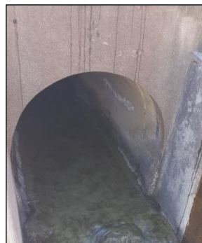
Fotografía N.º 12. Conducto Cubierto de la Presa – Laguna Paccharuri
