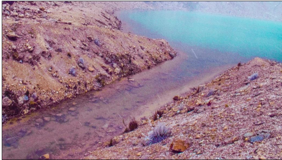
Fotografía N° 05. Canal de Descarga de la Laguna Llullacocha.
