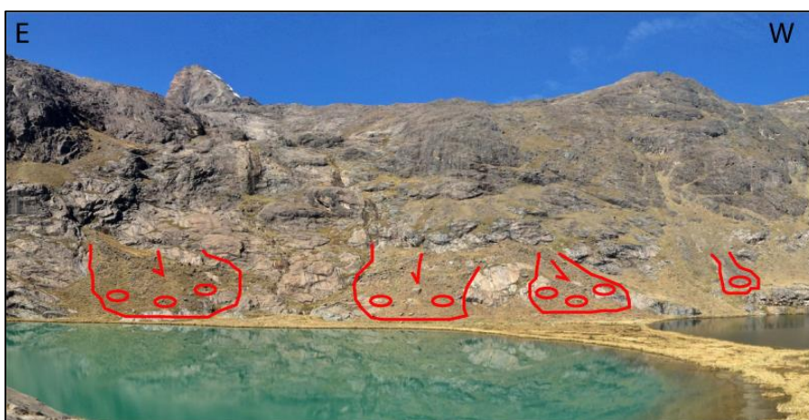
Fotografía N°07.- Ladera izquierda (aguas abajo) de la laguna Ticllacocha. Se observan cuatro zonas de caída de roca. La orientación de los planos de fractura es paralelo al talud, favoreciendo la caída de bloques.
