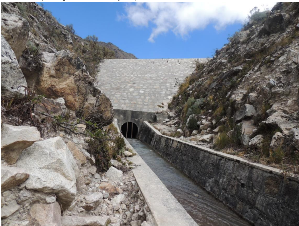
Fotografía N° 02: Vista del canal de aducción
