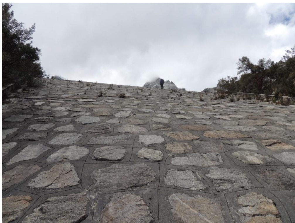
Fotografía N° 04: Vista del paramento del dique
