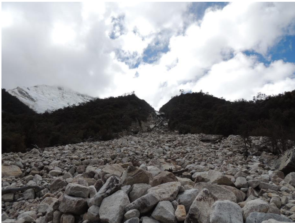
Fotografía N° 10: Vista donde se observa los daños producidos aguas abajo de la presa
