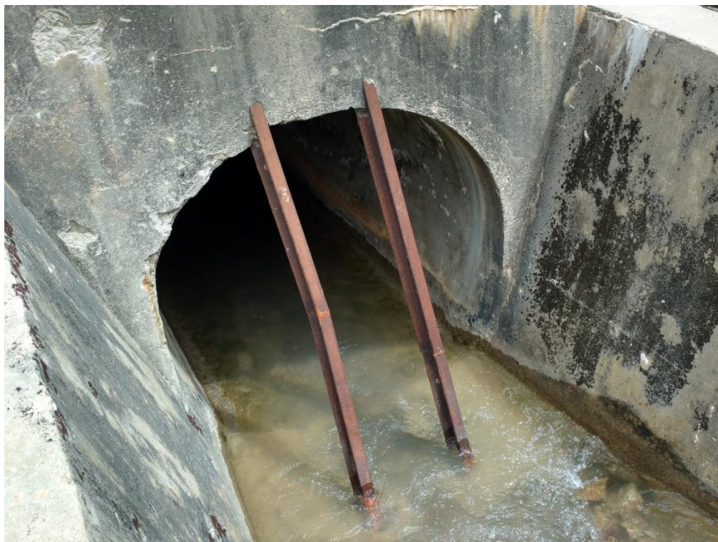
Fotografía N° 03: Vista del conducto cerrado
