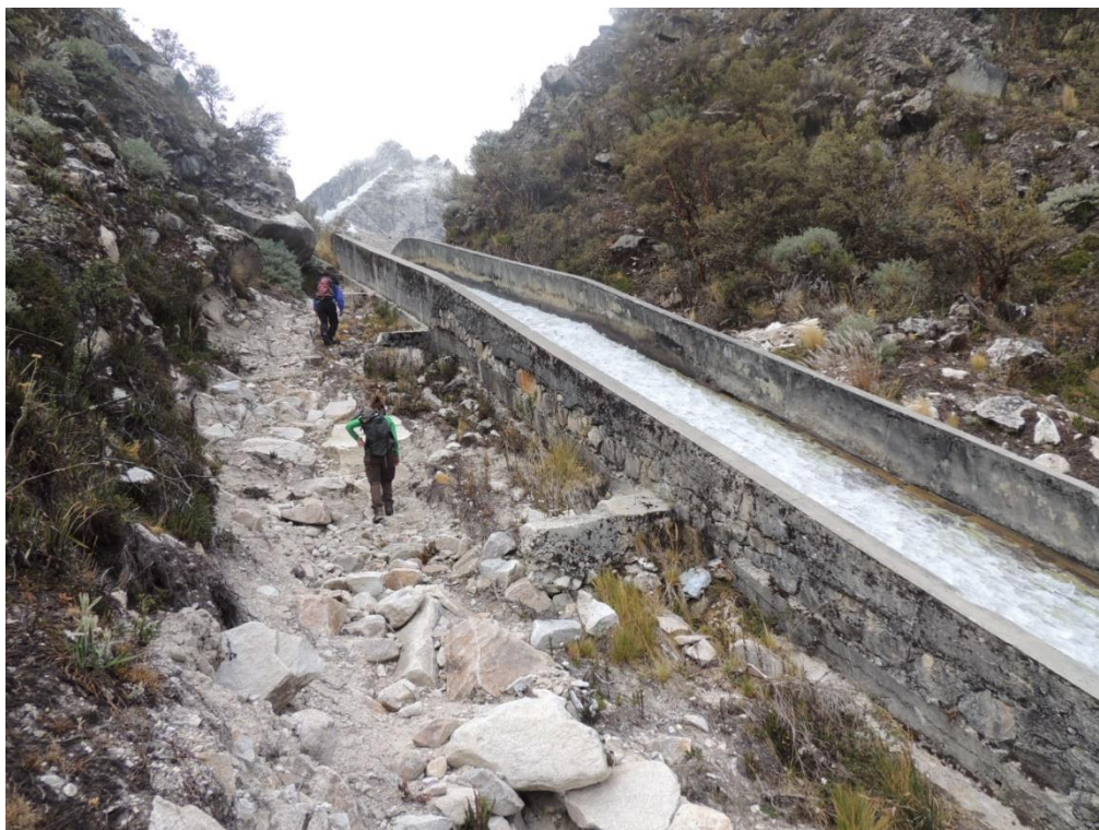
Fotografía N° 07: Vista de la rápida después del canal de salida
