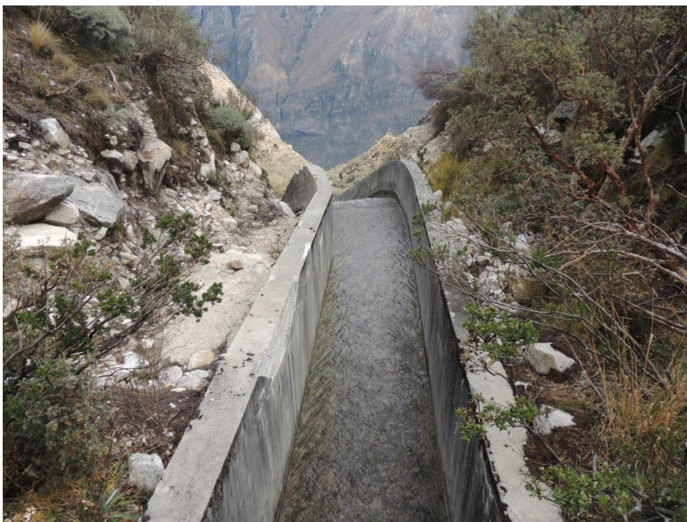
Fotografía N° 06: Vista del canal de salida
