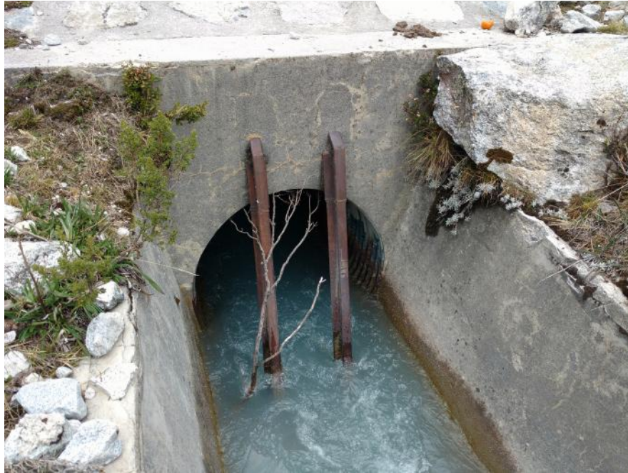
Fotografía N° 03: Vista de la entrada al ducto.
