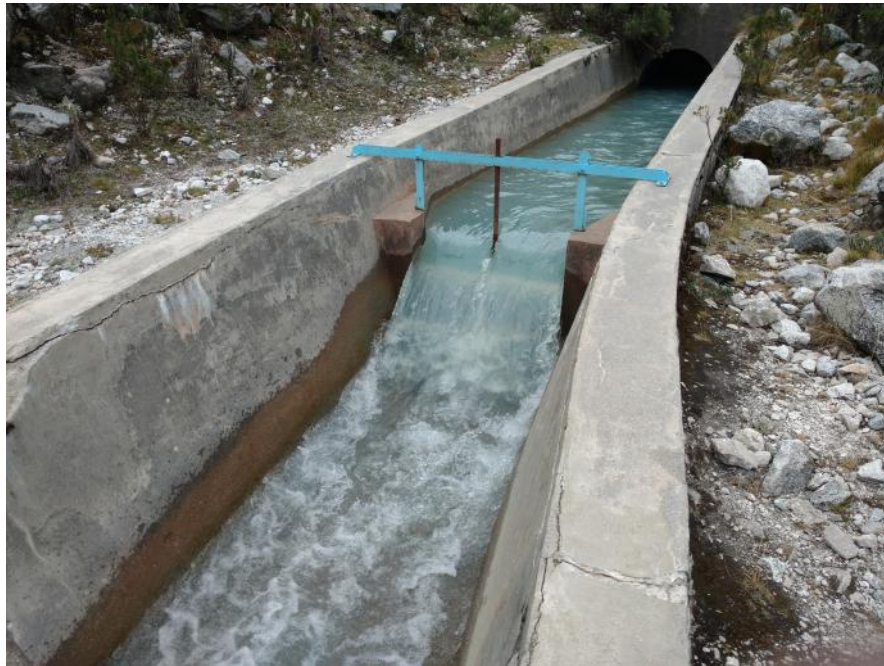
Fotografía N° 09: Vista del canal de salida.
