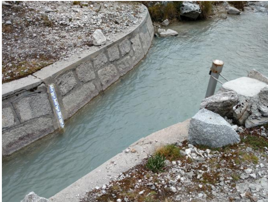
Fotografía N° 11: Regla limnimétrica y sensores para medir caudal (Canal de entrada).
