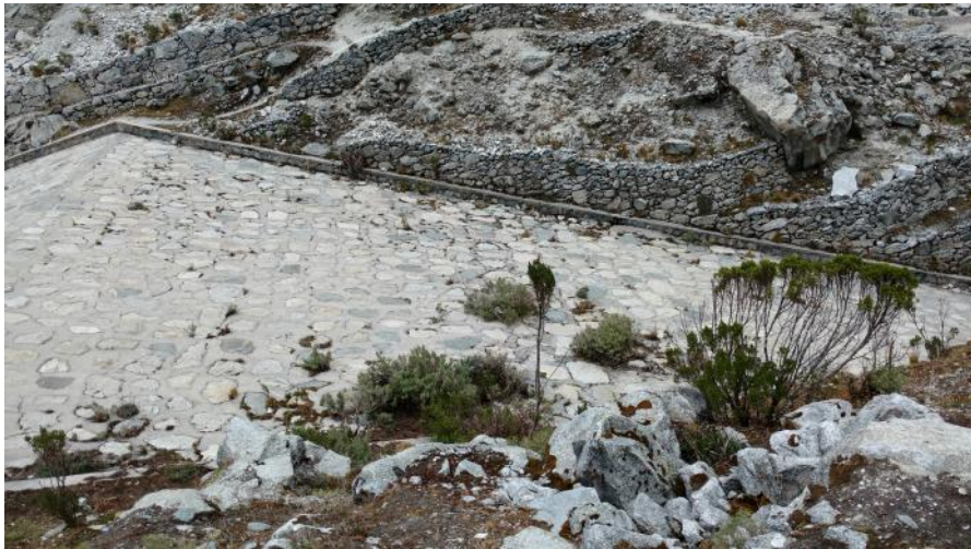
Fotografía N° 07: Vista del talud aguas arriba del dique.
