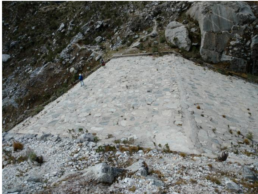
Fotografía N° 05: Vista panorámica del dique de Llaca.
