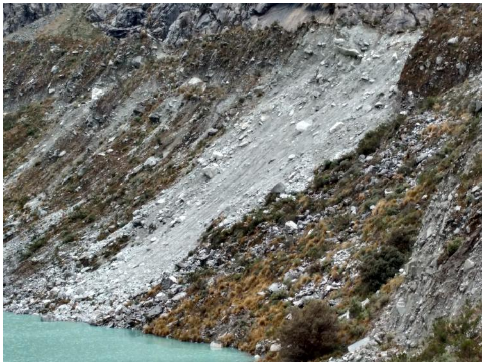
Fotografía N° 14: Vista del deslizamiento y cárcavas del talud interno de la morrena lateral izquierdo de la laguna Llaca.
