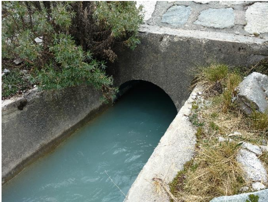
Fotografía N° 04: Vista de la salida del ducto.
