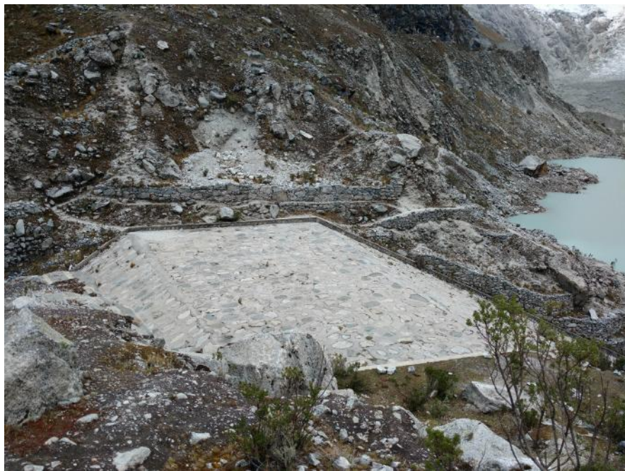
Fotografía N° 06: Vista de la plataforma de la corona del dique de Llaca.
