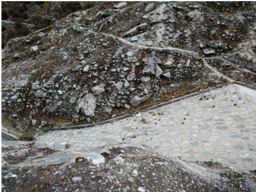
Fotografía N° 08: Vista del talud aguas abajo del dique.
