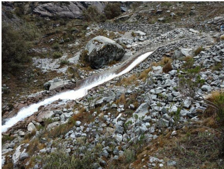
Fotografía N° 10: Vista de la rápida (caída inclinada).
