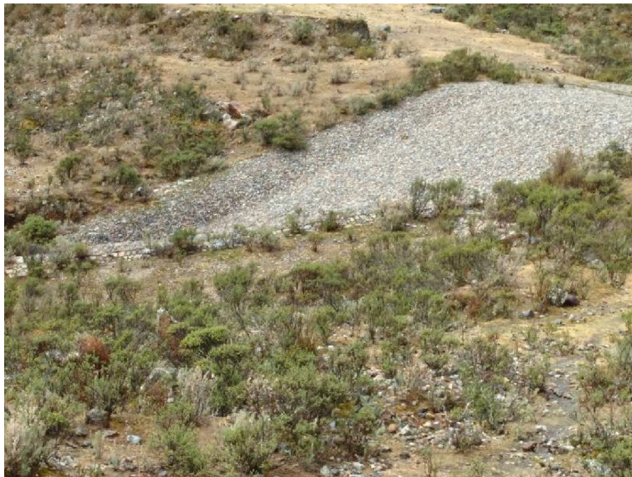
Fotografía N° 07: Vista del talud aguas arriba del dique.
