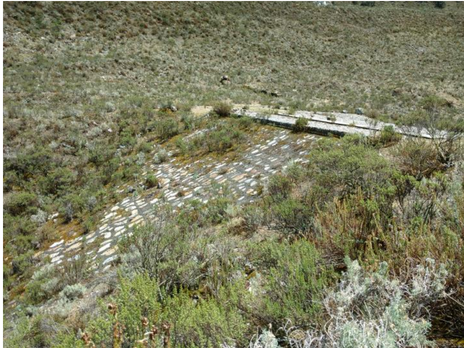
Fotografía N° 08: Vista del talud aguas abajo del dique.
