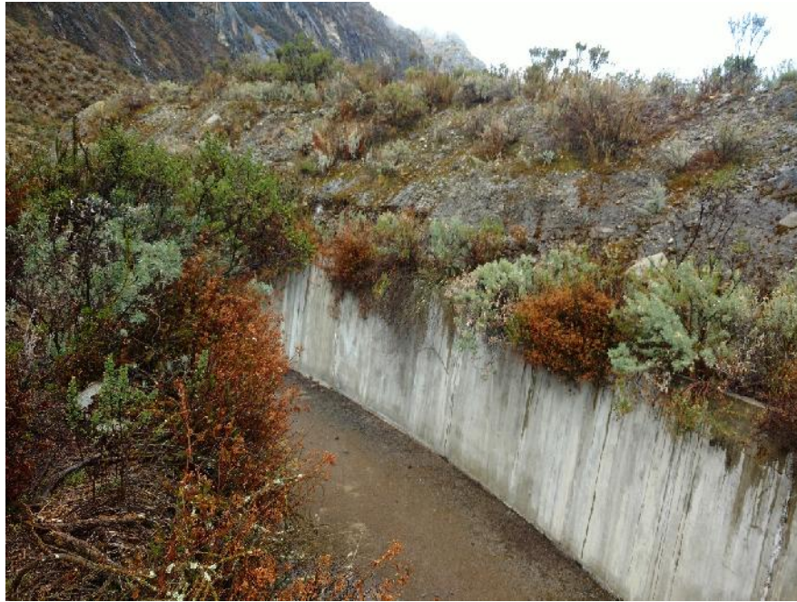
Fotografía N° 12: Vista del canal – Aliviadero.
