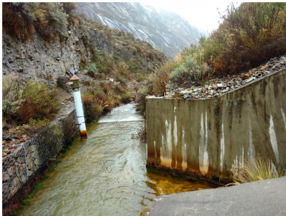
Fotografía N° 09: Vista de la zona donde bifurca el canal de salida y aliviadero.
