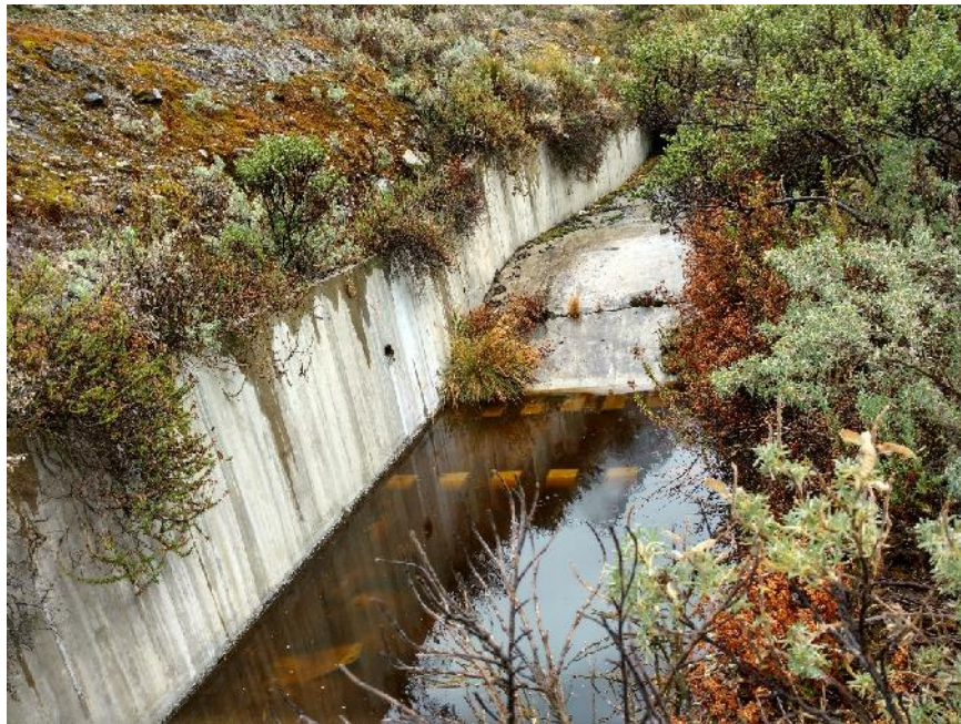
Fotografía N° 13: Vista del disipador de energía – Aliviadero.
