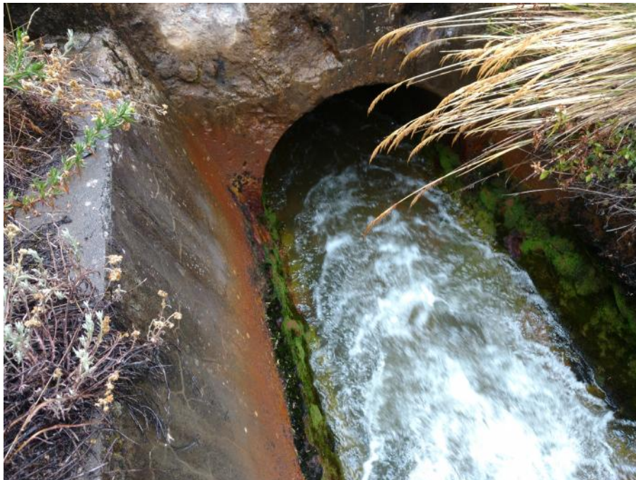
Fotografía N° 03: Vista del ducto de ingreso - Estructura de Control.
