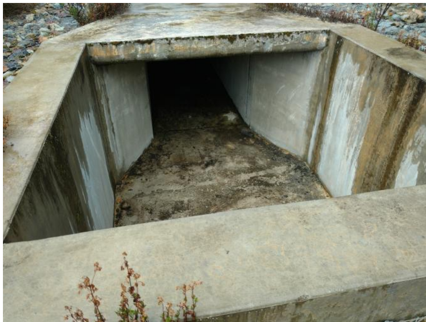
Fotografía N° 11: Vista del conducto cubierto – Aliviadero.
