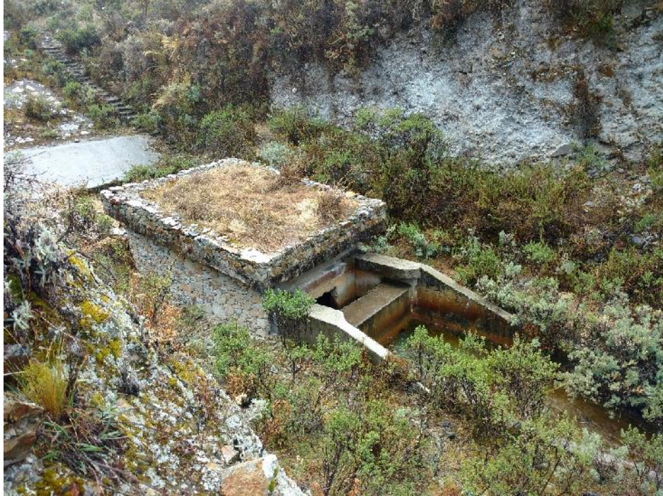
Fotografía N° 04: Vista de la caseta de válvulas y disipador de impacto - Estructura de Control.
