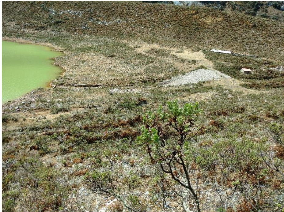
Fotografía N° 05: Vista panorámica del dique de Shallap.
