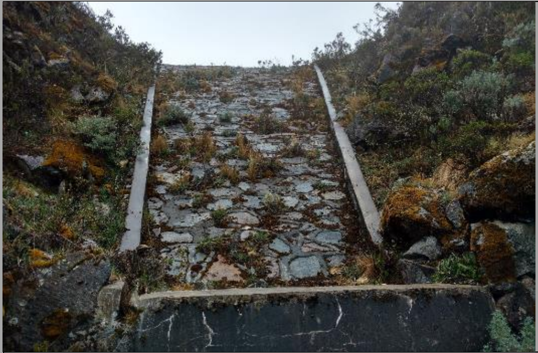
Fotografía N° 06: Vista del talud aguas arriba del dique.
