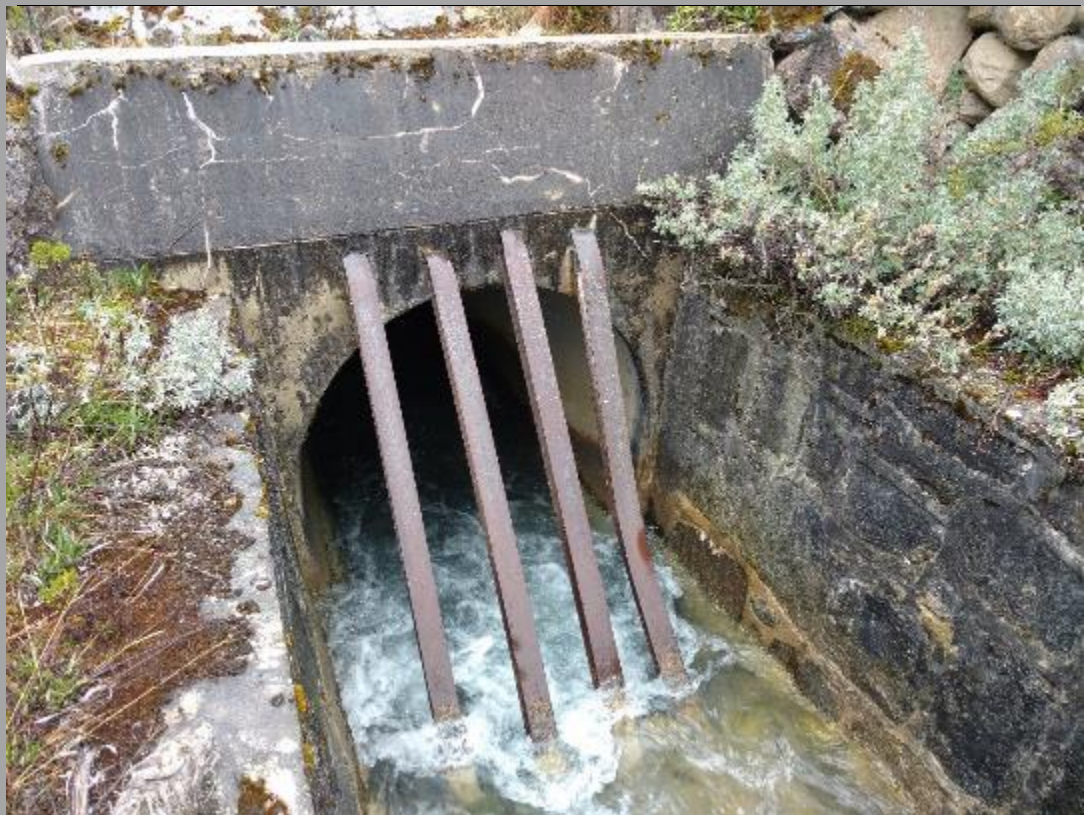
Fotografía N° 03: Vista de la entrada al ducto.
