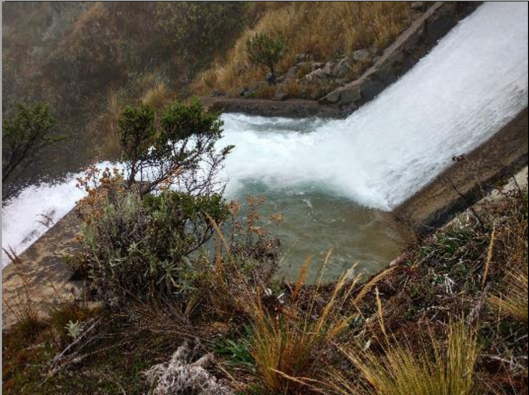
Fotografía N° 10: Vista de la poza de disipación.
