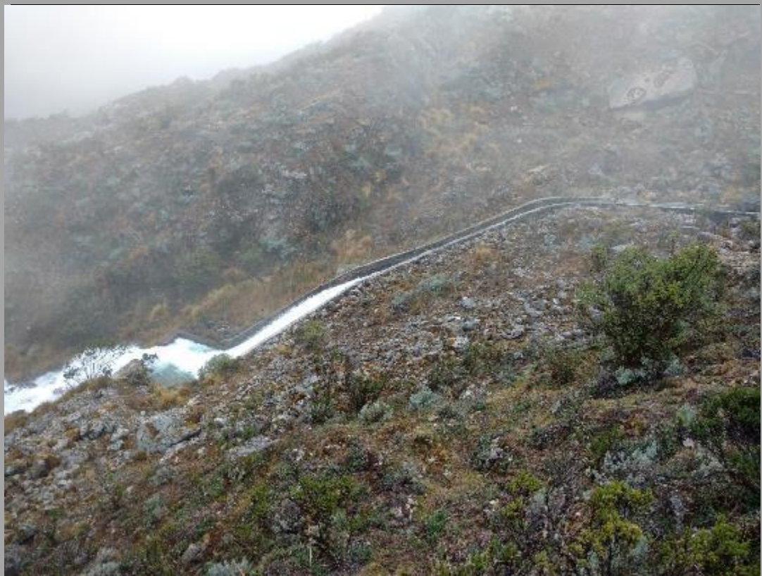
Fotografía N° 09: Vista de la rápida.
