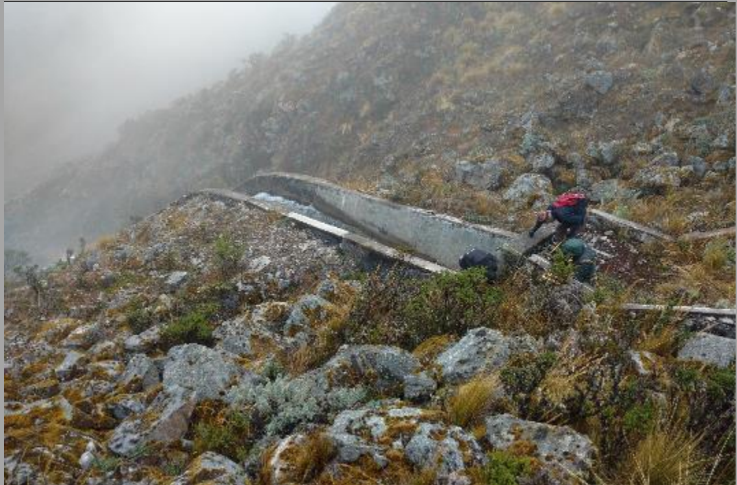
Fotografía N° 08: Vista del canal de salida.
