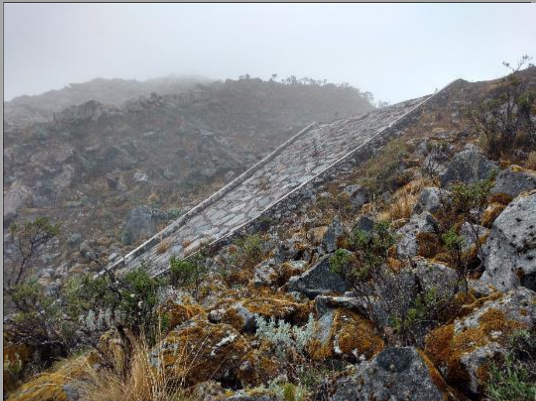
Fotografía N° 07: Vista del talud aguas abajo del dique.
