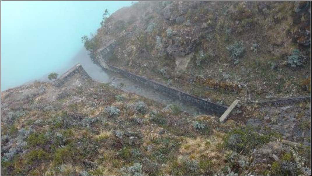
Fotografía N° 02: Vista del canal de entrada.
