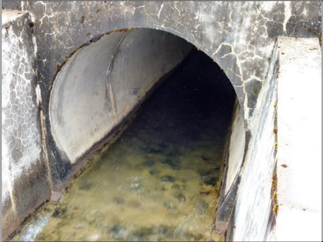
Fotografía N° 04: Vista de la salida del ducto.
