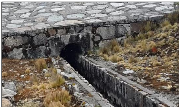
Fotografías N° 11. Vista del Conducto Cubierto – Laguna Akillpo
