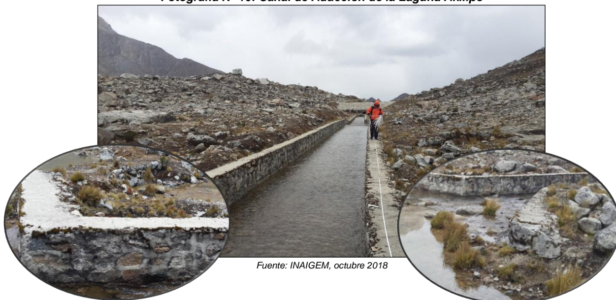
Fotografía N° 10: Canal de Aducción de la Laguna Akillpo
