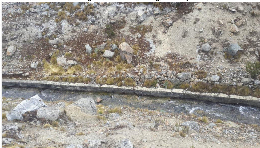
Fotografía N° 13: Canal Aguas Abajo
