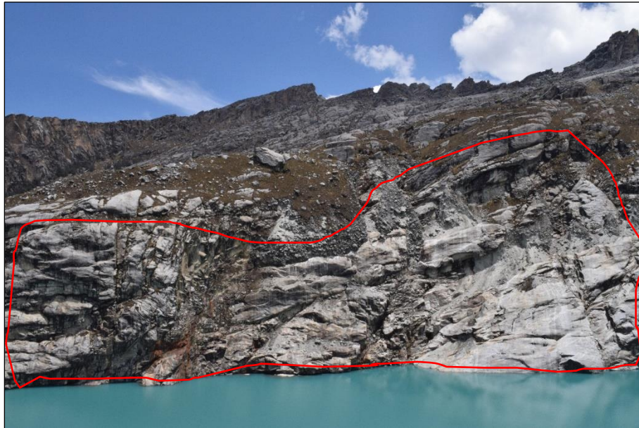
Fotografía N.º 04, Vista Panorámica del Macizo Rocoso que Compone el Vaso de Almacenamiento de la Laguna 513 – Vista Lateral Derecha.
