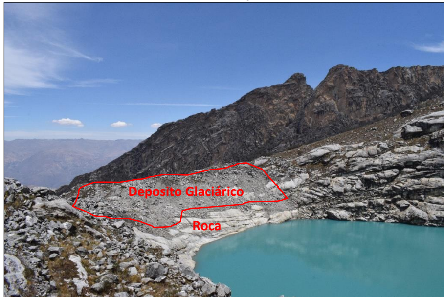
Fotografía N.º 02, Vista Panorámica del Depósito Glaciárico que Sobre Yace al Macizo Rocoso Frontal de la Laguna 513
