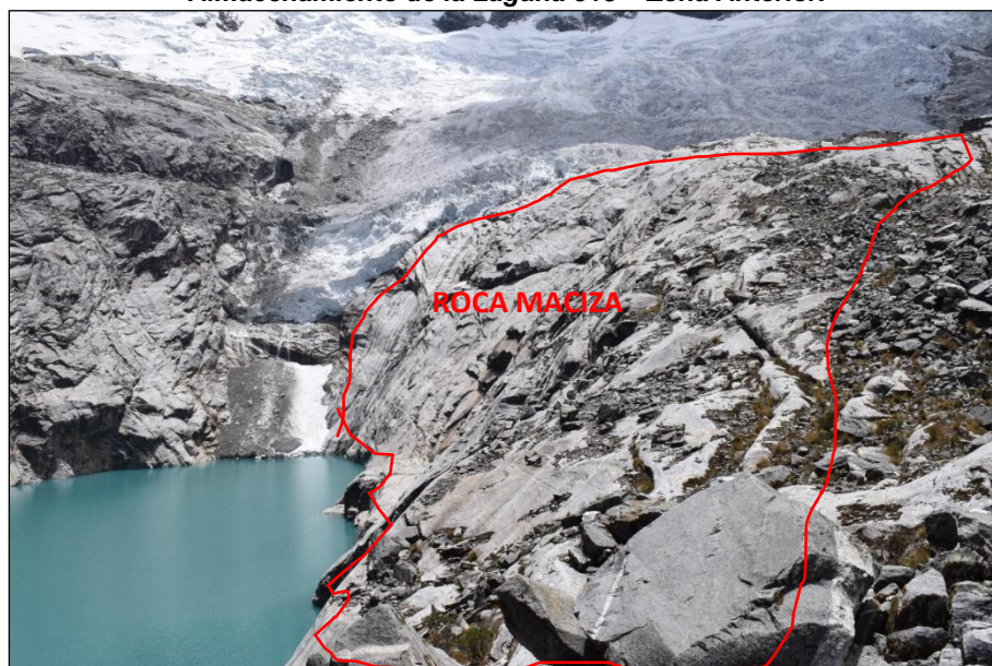
Fotografía N.º 03, Vista Panorámica del Macizo Rocoso que Compone el Vaso de Almacenamiento de la Laguna 513 – Zona Anterior.
