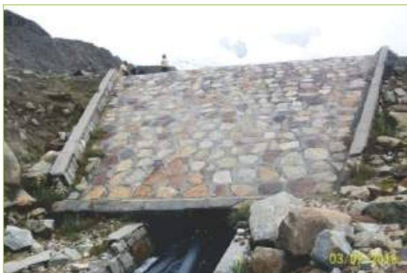
Fotografía 6. Vista del dique artificial de la laguna Palcacocha
