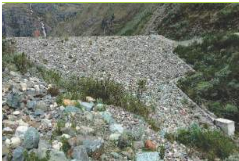
Fotografía 5. Vista del dique artificial de la laguna Rajucolta
