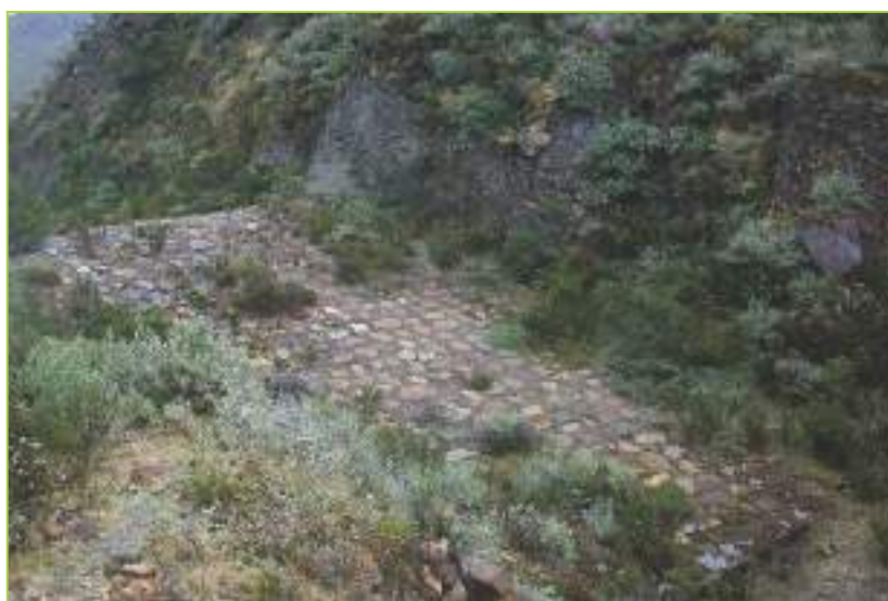
Fotografía 7. Vista del dique artificial de la laguna Tullparaju
