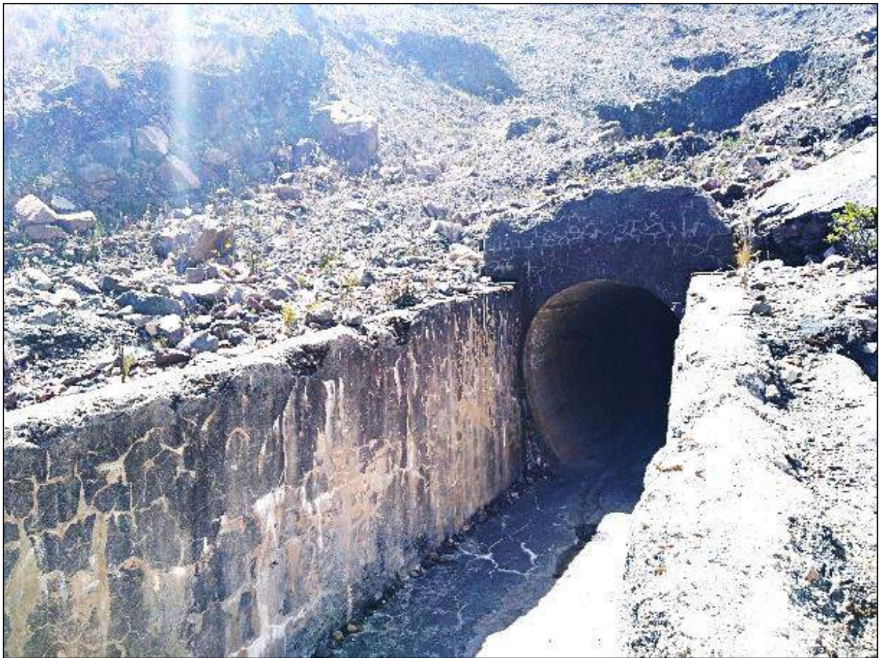
Figura 26. Conducto y canal de salida en la morrena frontal de la laguna Safuna Alta, Huaylas, Ancash.
