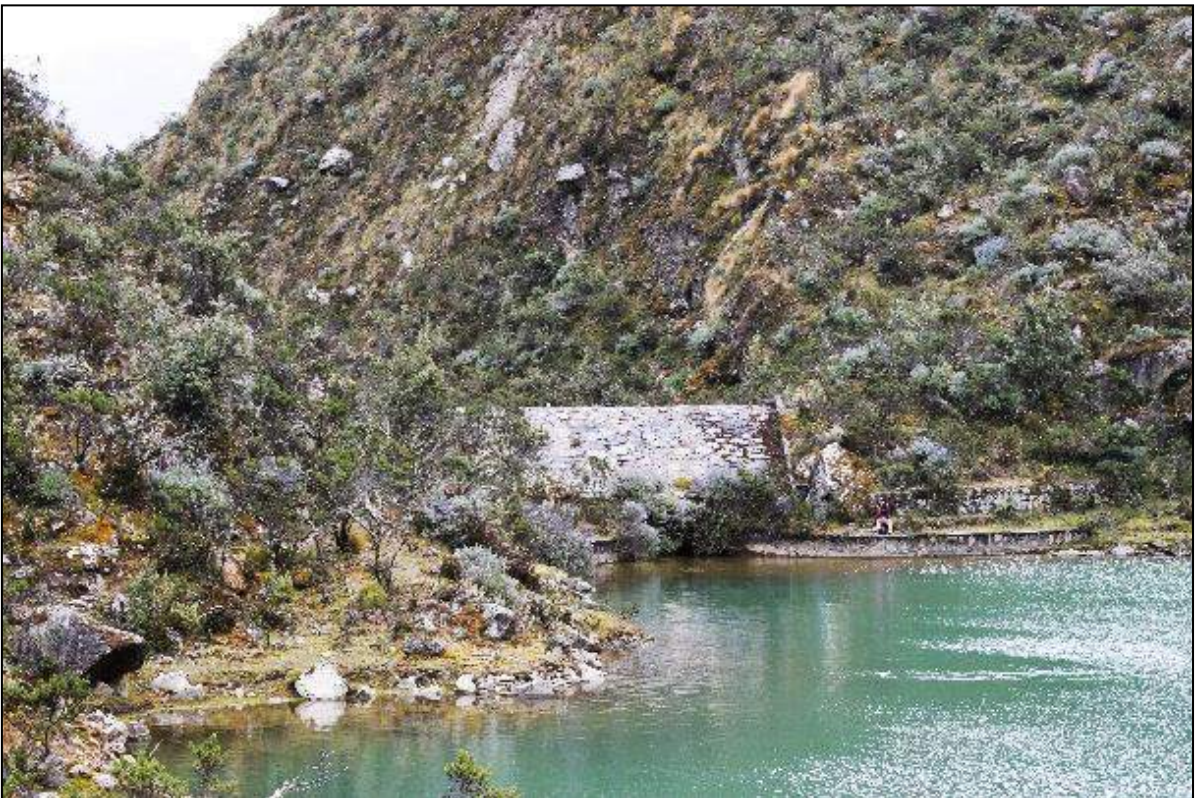
Figura 14. Dique de tierra revestido, conducto y canal de salida de la laguna Artesa, Carhuaz, Ancash.
