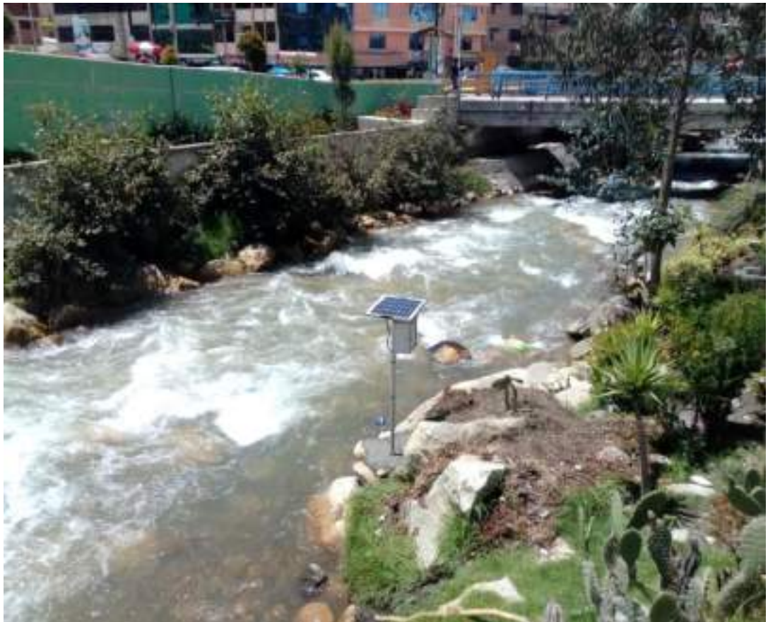
Figura 48. Limnógrafo instalado en el río Quillcay.
