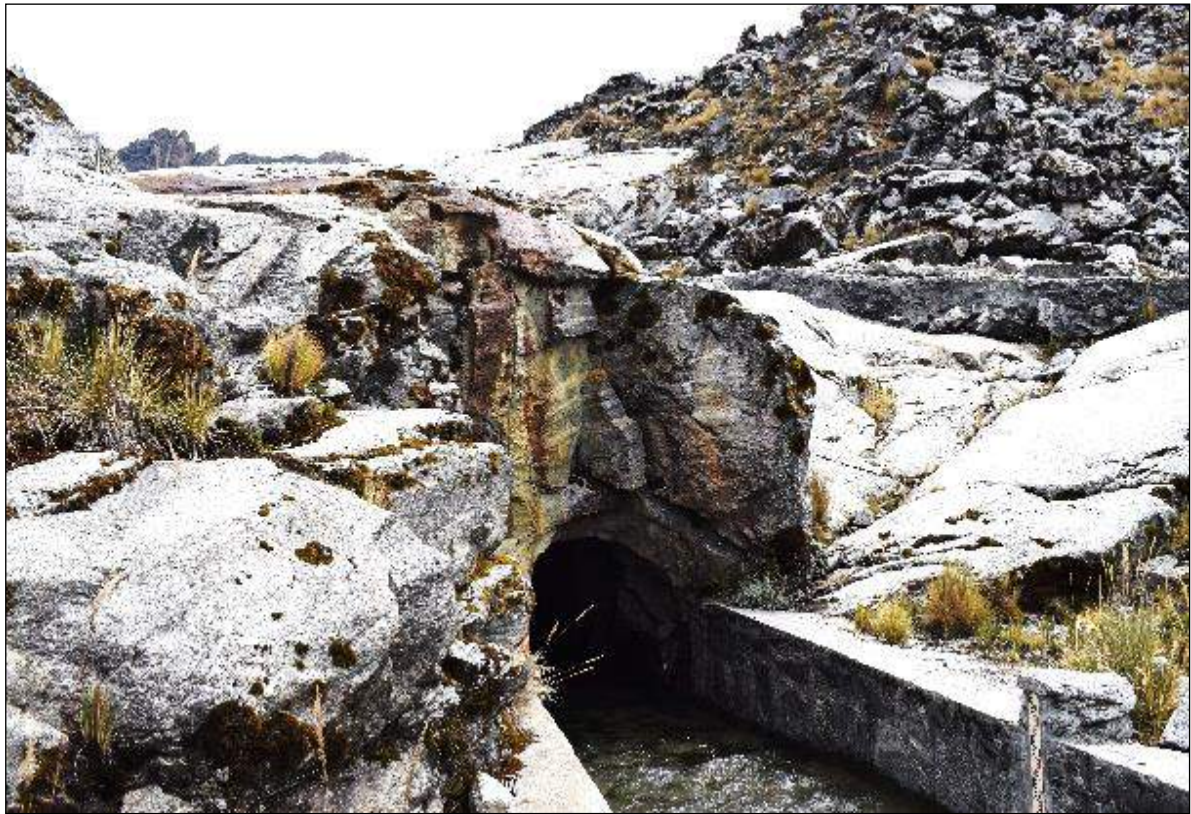
Figura 15. Salida del túnel de descarga de la laguna 513, Carhuaz, Ancash.
