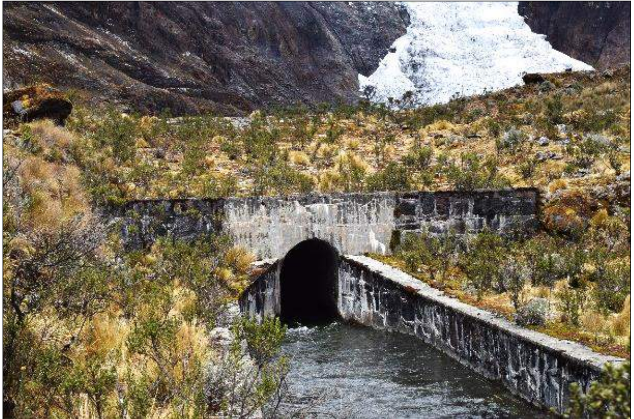
Figura 23. Dique de tierra revestido, conducto y canal de salida de la laguna Pucacocha, Huaylas, Ancash.
