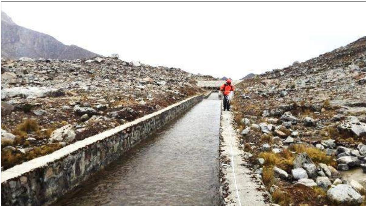
Figura 18. Dique de tierra revestido, conducto y canal de salida de la laguna Akilpo, Carhuaz, Ancash.
