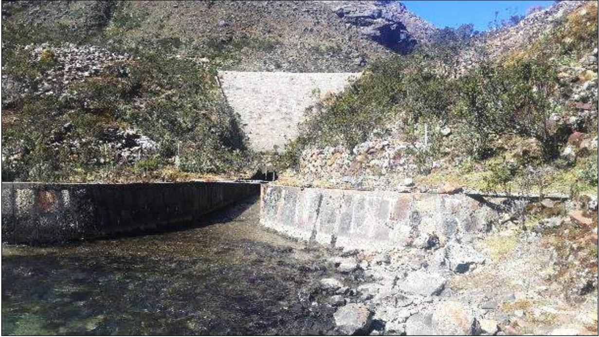
Figura 21. Dique de tierra revestido, conducto y canal de salida de la laguna Paccharuri, Carhuaz, Ancash.
