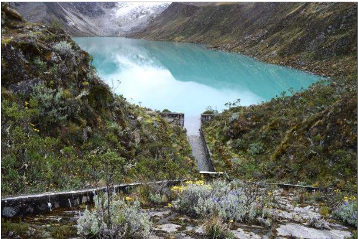
Figura 10. Dique de tierra revestido, conducto y canal de salida de la laguna Allicocha, Asunción, Ancash.
