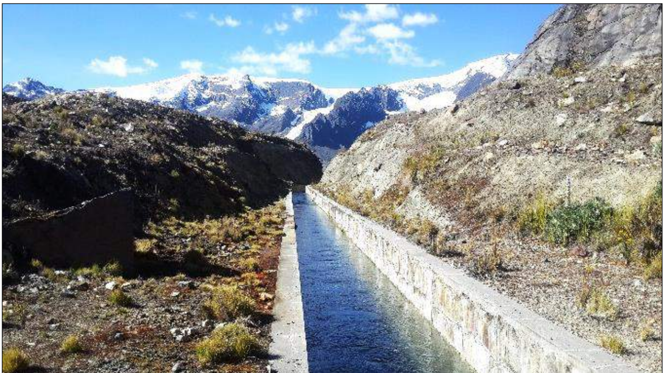
Figura 20. Canal de mampostería de piedra de la laguna Pacliascocha, Carhuaz, Ancash.
