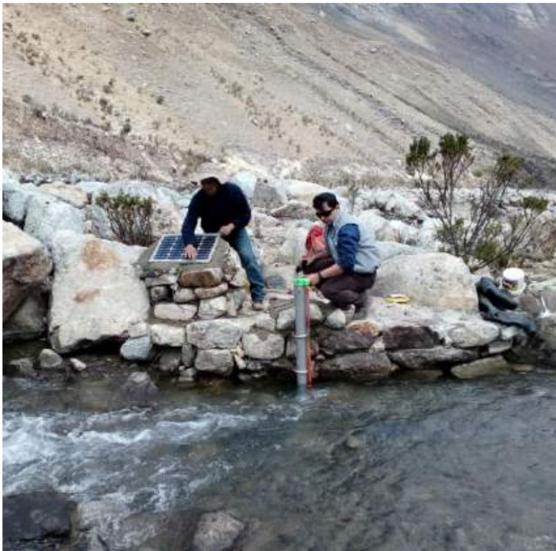
Figura 46. Limnógrafo instalado a la salida del sistema de sifonaje de la laguna Palcacocha.
