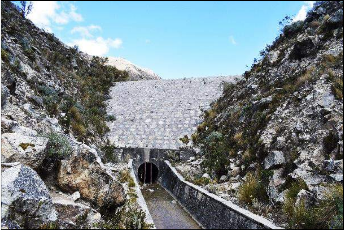
Figura 13. Dique de tierra revestido, conducto y canal de salida de la laguna Huallcacochoa, Carhuaz, Ancash.
