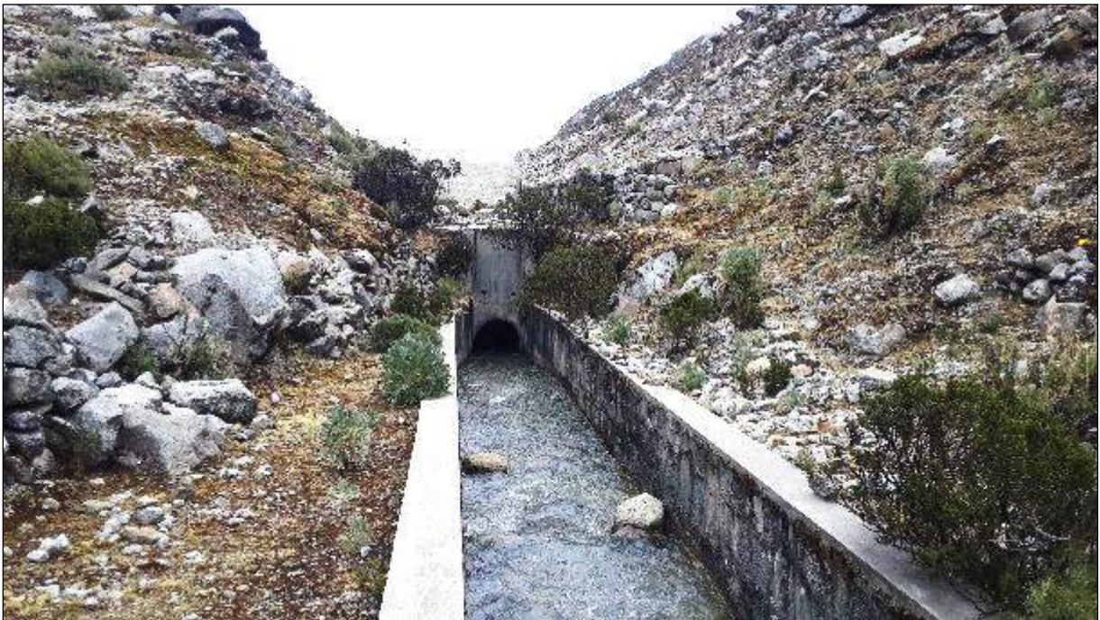
Figura 22. Dique de tierra revestido, conducto y canal de salida de la laguna Lejiacocha, Carhuaz, Ancash.
