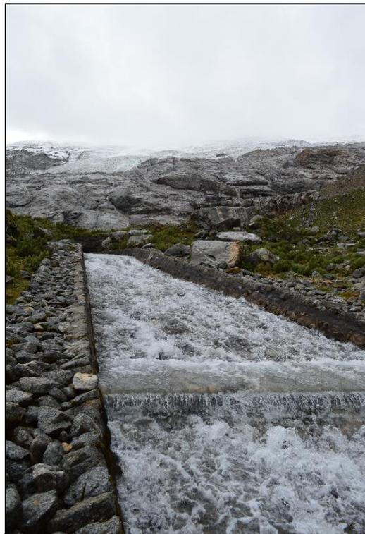
Fotografía N° 2: Canal de salida (Rápida) de la laguna Mullaca.
