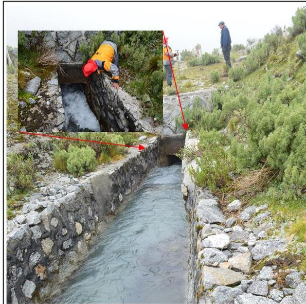
Fotografía N° 11: Canal de ingreso y dique de seguridad de la laguna Mullaca.
