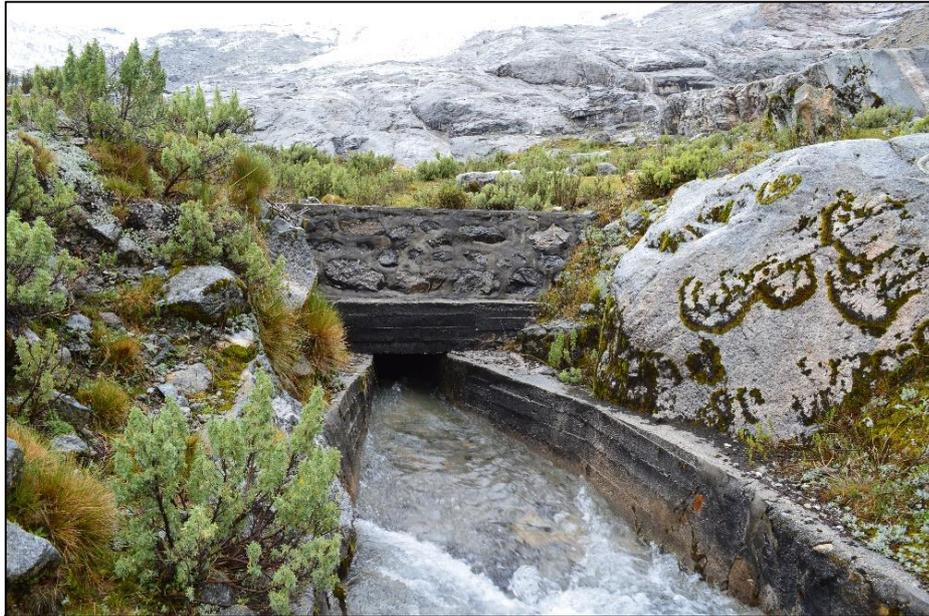
Fotografía N° 13: Canal de salida y rápida de la laguna Mullaca.
