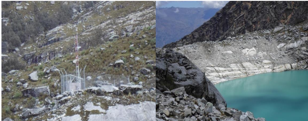
Fotografía N° 04.- Vista principal del Sistema de Alerta Temprana instalado en la laguna 513, sobre la margen derecha del dique de roca por encima del túnel existente. Este sistema permite alertar a la población en caso de producirse un evento extraordinario.
