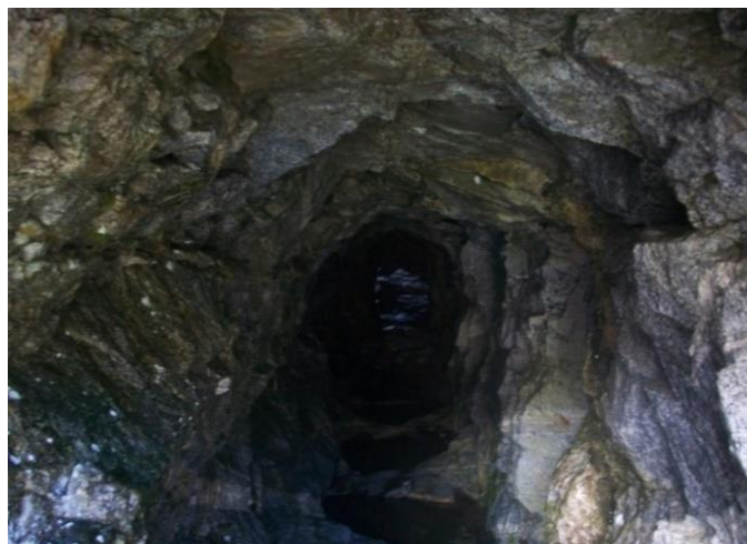
Fotografía N° 09. Vista del interior de la galería de descarga temporal.
