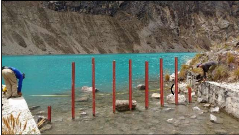
Fotografía N° 78: Zona de Ingreso al Canal de Desagüe de la Laguna Arhuaycocha.
