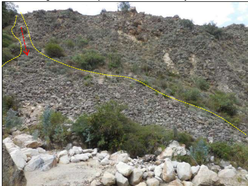
Fotografía N° 68: Depósito de Caída de rocas y detritos.
