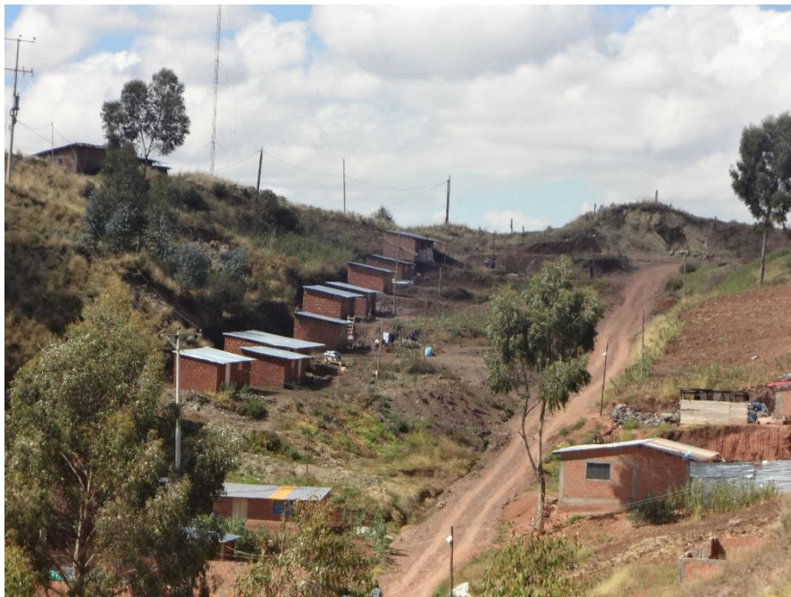
Fotografía 5: Depósitos de rellenos en cárcava, donde actualmente se emplazan vías y calles. Fuente: Equipo Técnico PM41ZRE
