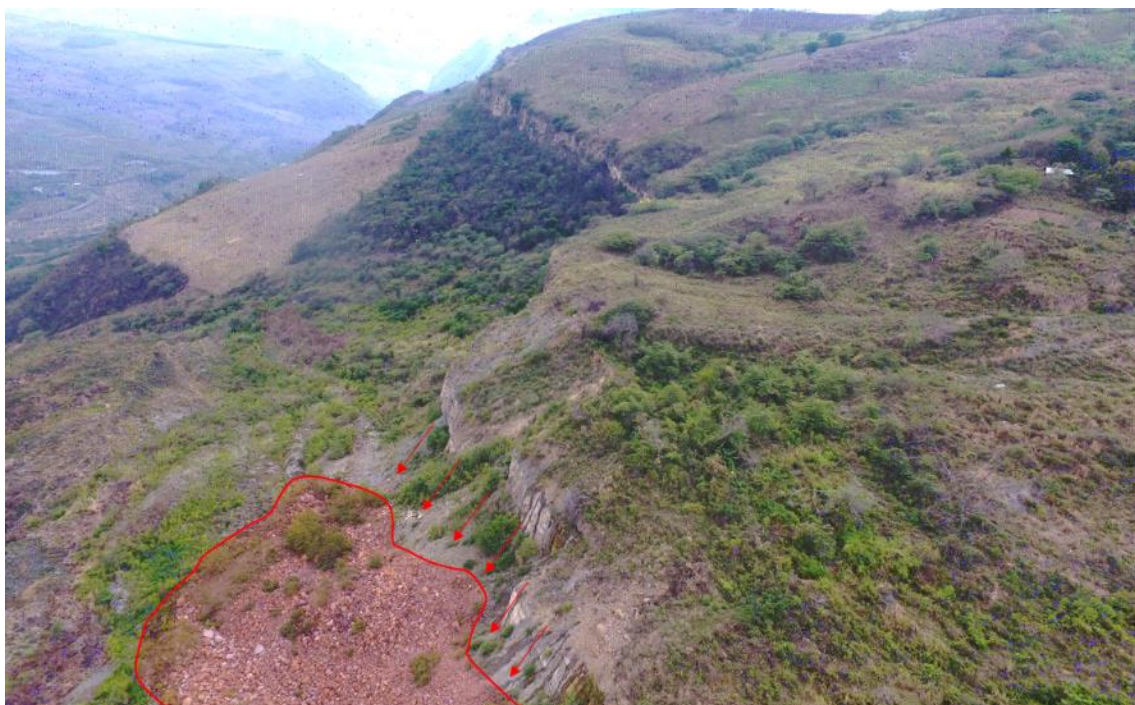
Figura 14. Derrumbe, en el flanco izquierdo del escarpe principal, material constituido por lutitas, limoarcillas y nódulos calcáreos, meteorizados muy deleznales.
