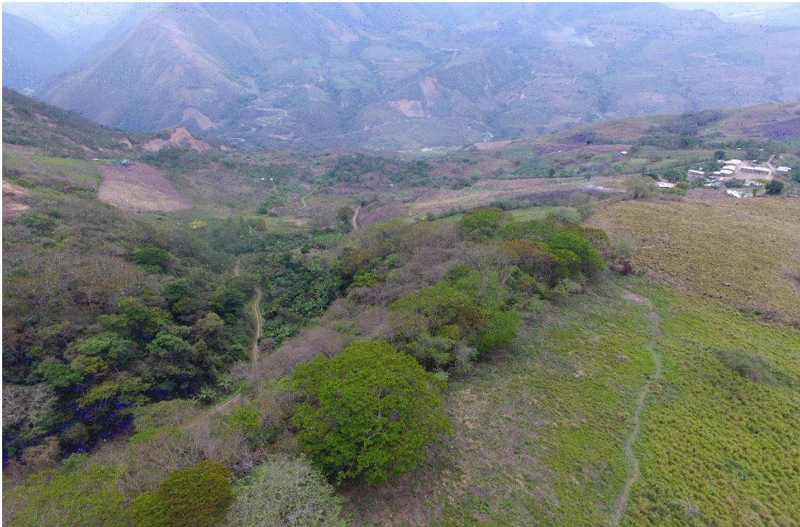
Fotografía 7. Vista panorámica de la zona afectada, vista de norte a sur.
