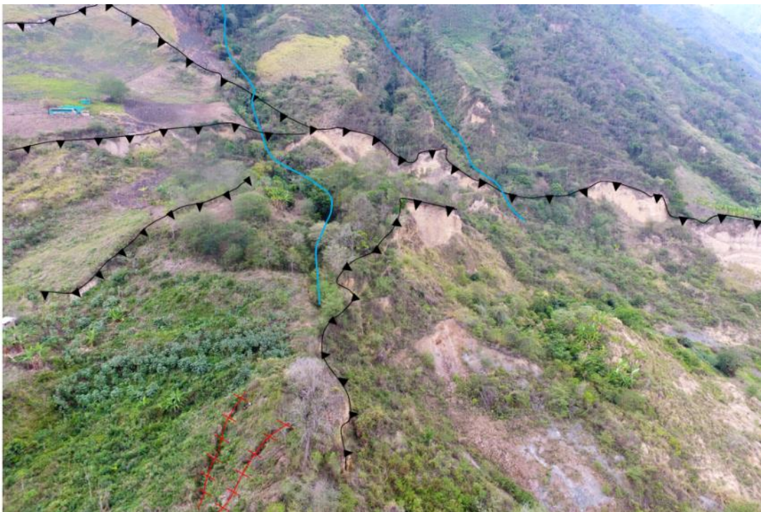
Figura 12. Escarpes secundarios dentro del cuerpo del deslizamiento y agrietamientos con 9 m de largo y 0.40 m de ancho.
