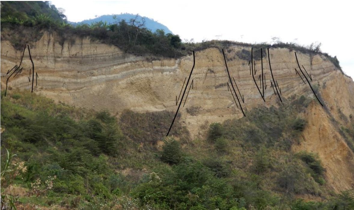
Figura 9. En la foto se puede ver un sistema de fallas conjugadas en donde la principal tiene una dirección N45°E, inclinación de 70°, ubicado en las coordenadas UTM WGS-84, Zona 17S, Este:815098 y Norte: 9349833..
