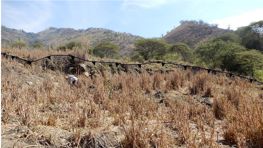
Figura 9. Escarpe secundario ubicado dentro del cuerpo deslizado en el sector Los Valles, bajo el escarpe se identifican cultivos agrícolas con prácticas de riego por inundación.
