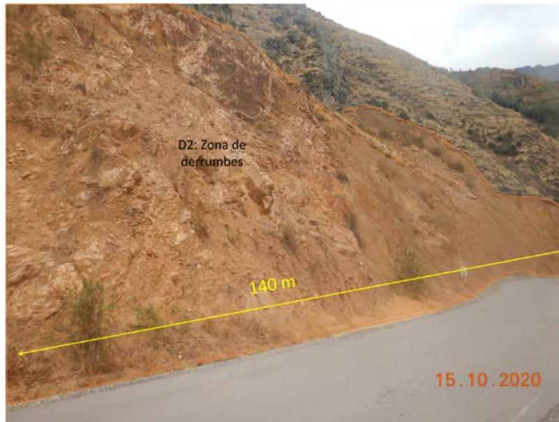
**Figura 17.** Se aprecia el ancho de la zona de derrumbe D2.
