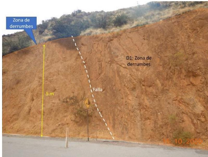
**Figura 15.** Vista tomada en coordenadas UTM (GWS184-Zona 19s) E 192279; N 8516251. Se aprecia la altura de la zona de derrumbe D1, además la presencia de una falla que pasa por medio.
