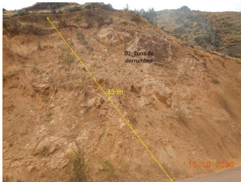
**Figura 16.** Vista tomada en coordenadas UTM (GWS184-Zona 19s) E 192353; N 8516367. Altura de la zona de derrumbe D2.
