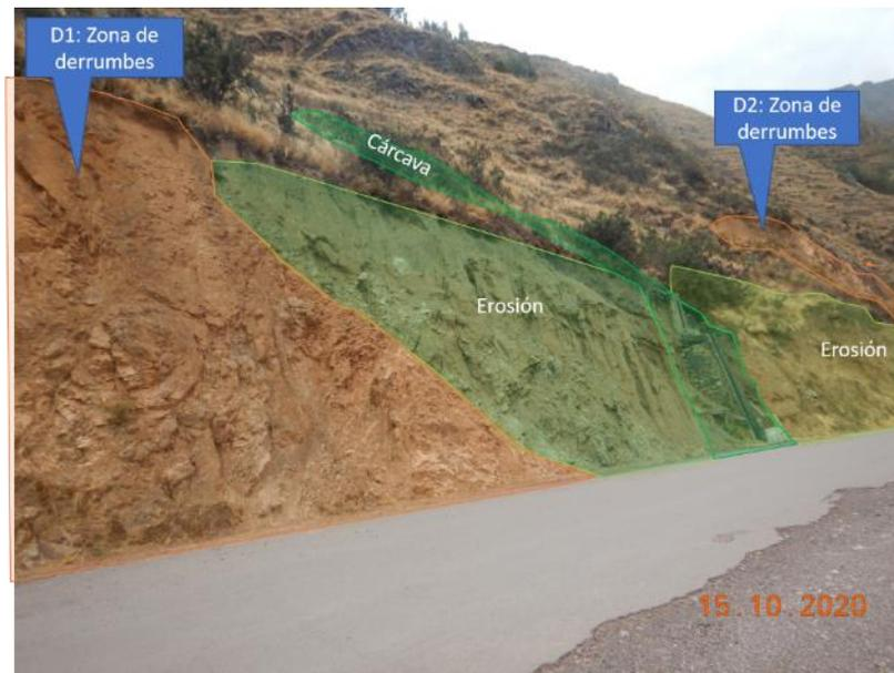
**Figura 10.** Se aprecia la zona de derrumbes D1 y D2, en medio las zonas de erosión y una cárcava que se está generando por la falta de mantenimiento de la zanja de drenaje que se ubica al medio.
