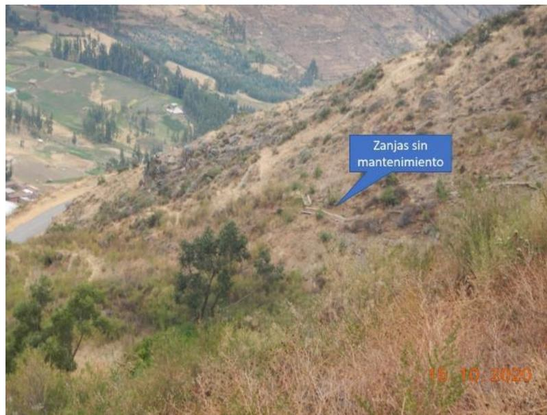
**Figura 12.** Vista tomada en coordenadas UTM (GWS184-Zona 19s) E 192308; N 8516305. Vista al sureste de la vía intihuatana zanja de drenaje en pésimas condiciones, debido al deslizamiento del año 2010 .
