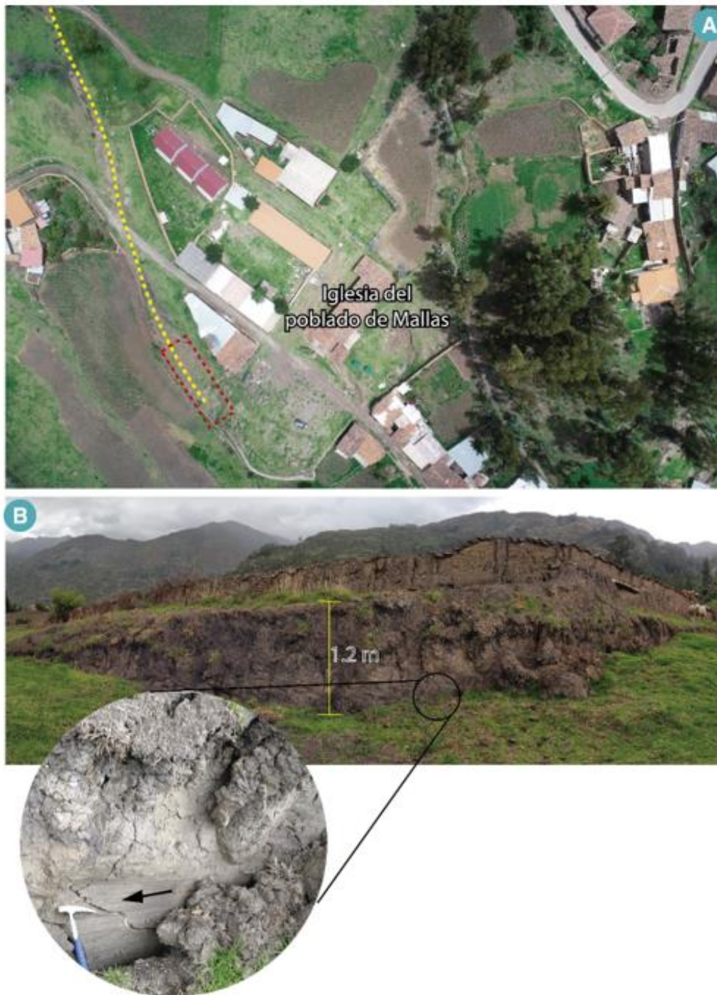
Figura 22. Escarpe lateral en el cuerpo del deslizamiento 1 (DES-1), con dirección sureste, noreste con una longitud de aproximadamente 400 m, tiene una altura promedio de 1.2 m, el acercamiento de la figura muestra estrías de desplazamiento que revelan una dirección de movimiento suroeste. (Coordenadas: 259331 E, 8959979 N).
