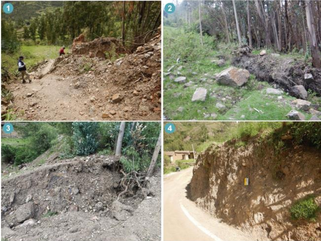
Figura 10. Imágenes donde se pueden evidenciar material de depósitos coluviales conformado por clastos y bloques de rocas sedimentarias como areniscas cuarzosas, envueltos en material fino de naturaleza limo-arcillosa, ubicados dentro del cuerpo del deslizamiento, sobre el cual se sitúa el centro poblado de Mallas.
