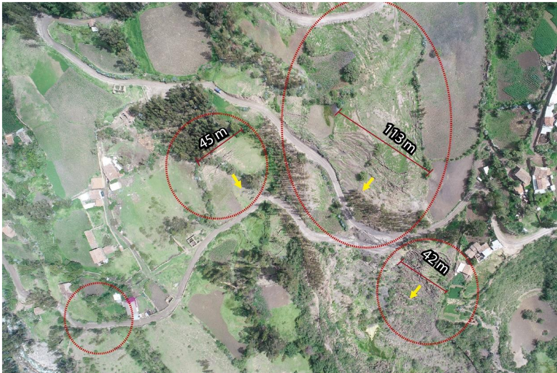
Figura 24. Grietas en el cuerpo del deslizamiento 2 (DES-2), llegan a alcanzar hasta 113 m de longitud de aperturas entre 50 cm y 1 m.
