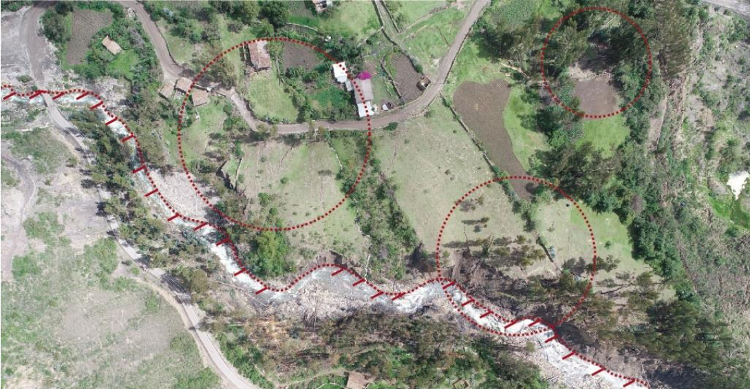
Figura 19. Se muestra el proceso de erosión (socavamiento) del río Rurichinchay en la ladera del depósito coluvial (pie del deslizamiento), que favorece la inestabilidad del cuerpo deslizado, por ello tenemos áreas con formación de agrietamientos en los terrenos, con longitudes de hasta 60 m, anchos de 1 m y profundidades visibles de 3 m (señaladas con líneas entrecortadas rojas)
