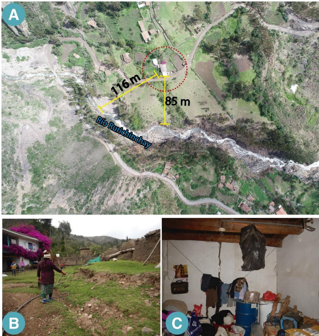
Figura 30. A) Muestra la ubicación de una vivienda habitada, se ubicada a 116 y 85 m del río, donde se evidencia inestabilidad. B) Muestra agrietamientos del terreno y escarpes secundarios C) Se observan los muros de la vivienda agrietada (0.8 a 10 cm), en las coordenadas del 258891 E, 8959098 N.
