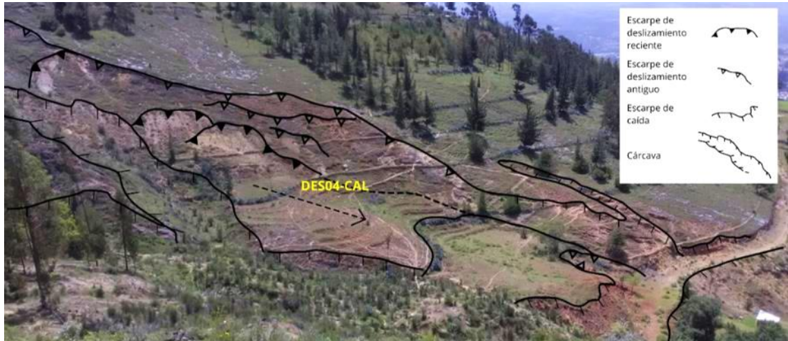
Figura 12. Comportamiento del deslizamiento compuesto DES04-CAL, en la margen izquierda de la quebrada Dos Aguas.
