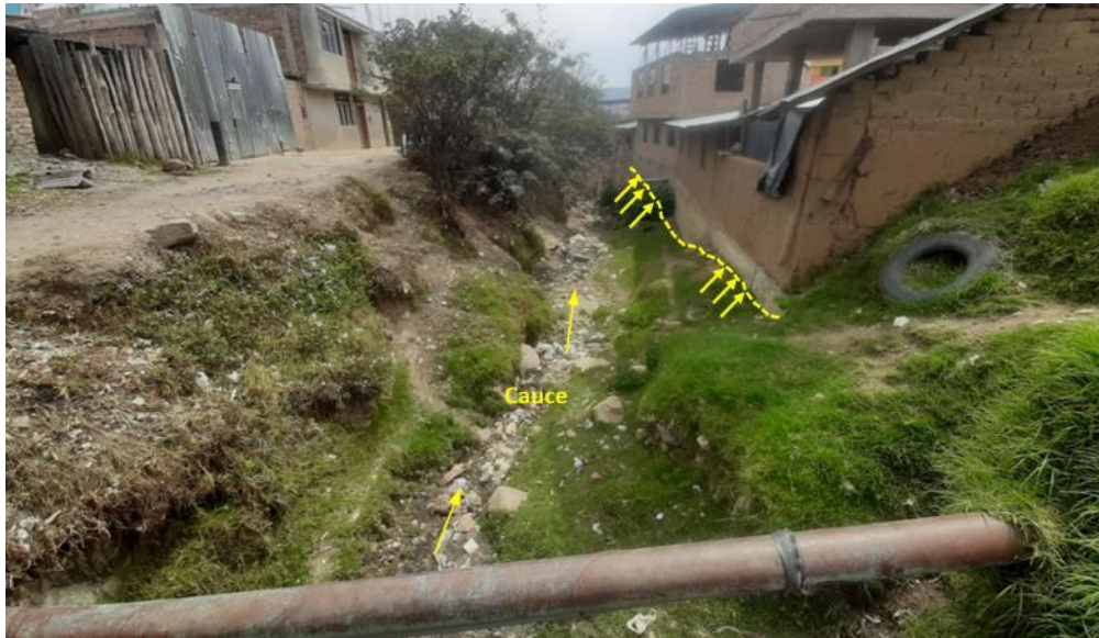
Figura 22. Emplazamiento de viviendas en riesgo, en la ribera de la quebrada Calispuquio (774779 E / 9206842 N).
