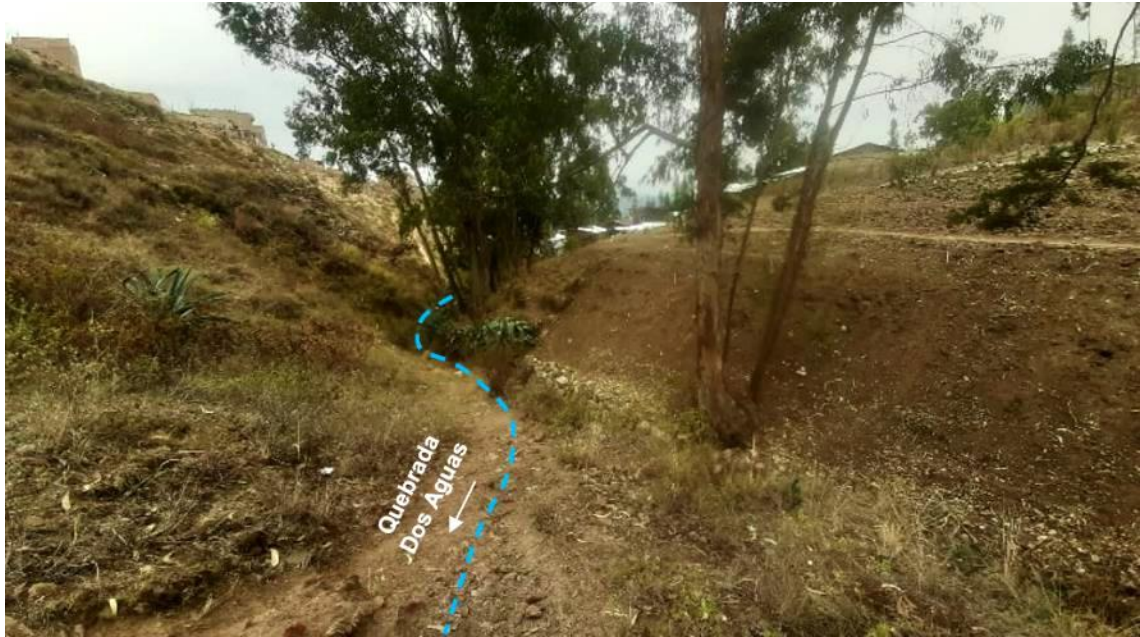
Figura 18. Erosión de laderas hacia la margen izquierda de la quebrada Dos Aguas, nótese superficies desprovistas de vegetación (774199 E; 9206734 N).
