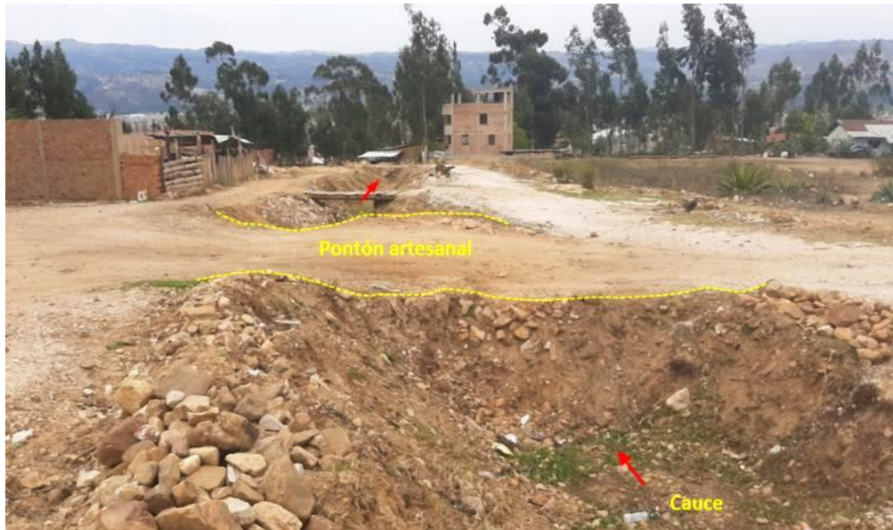
Figura 24. Acondicionamiento de pontones artesanales por los pobladores ocluyendo el cauce de la quebrada Arcomayo (774924 E / 9205144 N).
