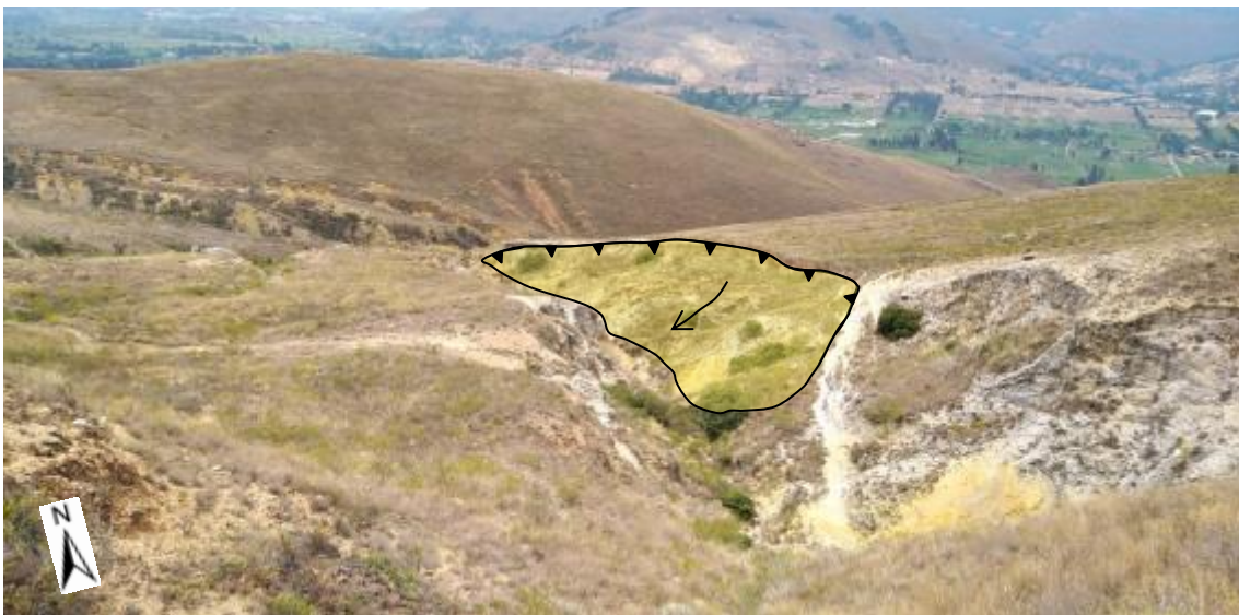
Figura 14. Vista ladera abajo del deslizamiento próximo a la quebrada La Colpa.
