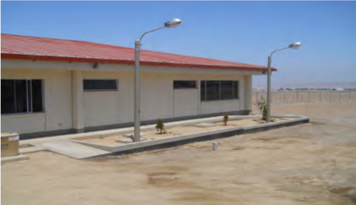
Vista Panorámica del Centro de Operaciones de Emergencia de la Región de Tacna.
