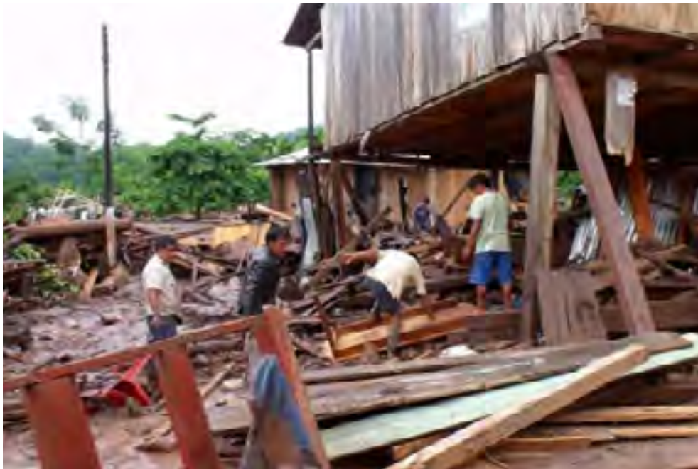
Viviendas destruidas por acción del huaico e inundación
