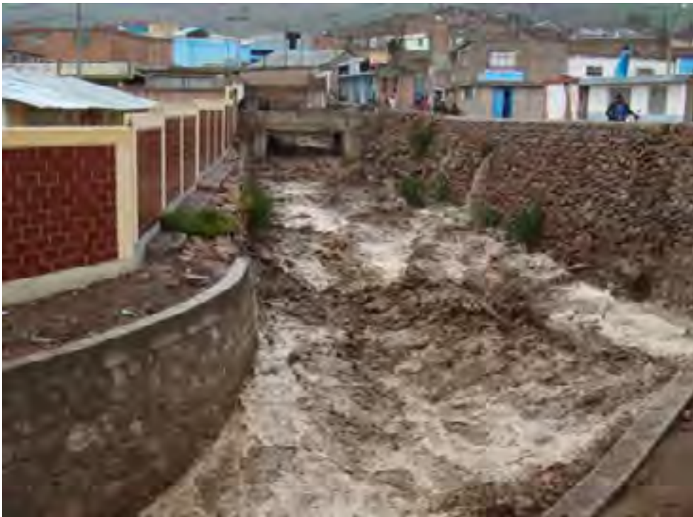
Fuertes precipitaciones pluviales, en la provincia y distrito de Candarave, enero 2011.
