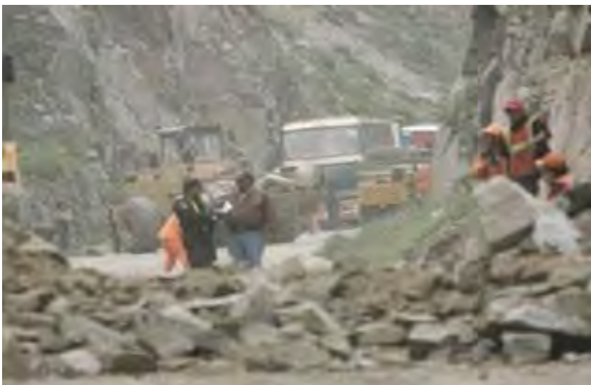
Deslizamiento del cerro Pucruchacra, distrito de San Mateo, provincia de Huarochirí, agosto 2011.
