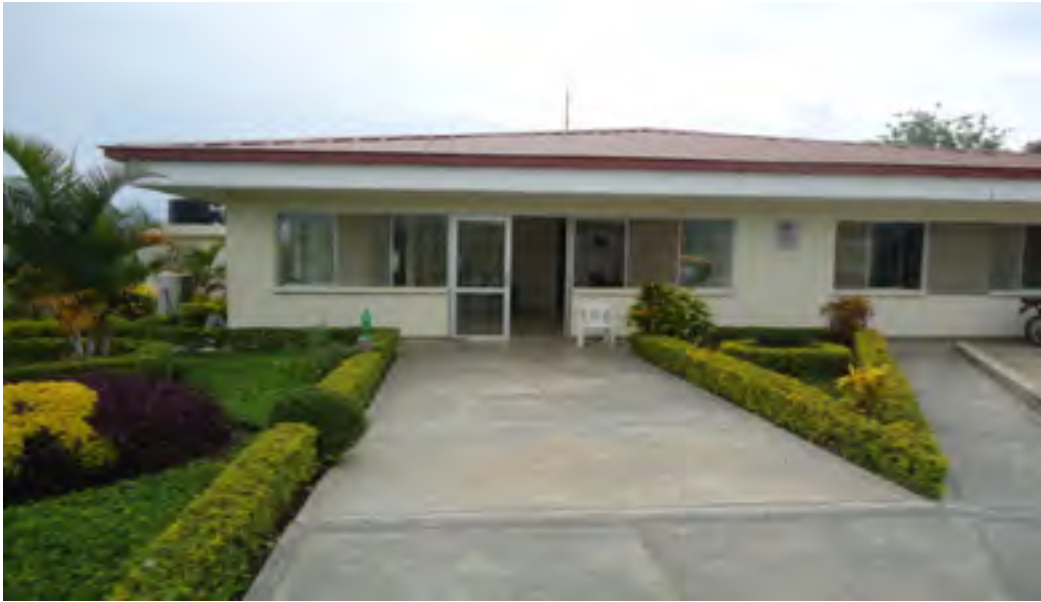
Vista panorámica de las Instalaciones del COER San Martín. Está en proceso de Implementación por parte del Gobierno Regional de San Martín y la adquisición de equipamiento adecuado y mobiliario.
