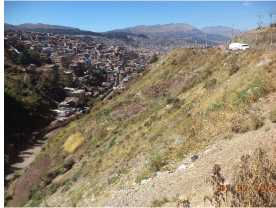
Fotografía 13: Cauce impactado por viviendas, parte alta quebrada Sipaspucyo Fuente: Equipo Técnico SGOT/PM41ZRE
