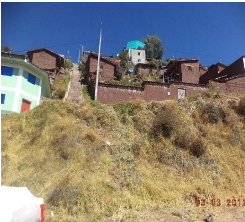
Fotografía 15.- Material de relleno, tomada extremo sur del área ZRECU10-A
