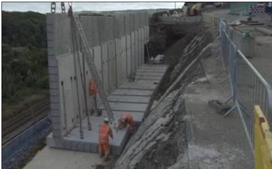
Imagen N° 1: Muro de contención tipo voladizo
