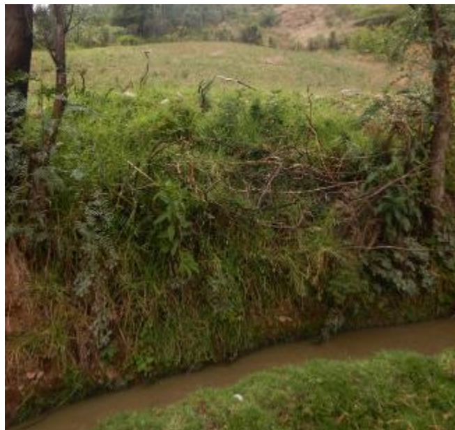
Figura 16. Se observa que los canales de riego existentes en el sector Shancayan y alrededores, no presentan revestimiento, como se muestra en la fotografía.
