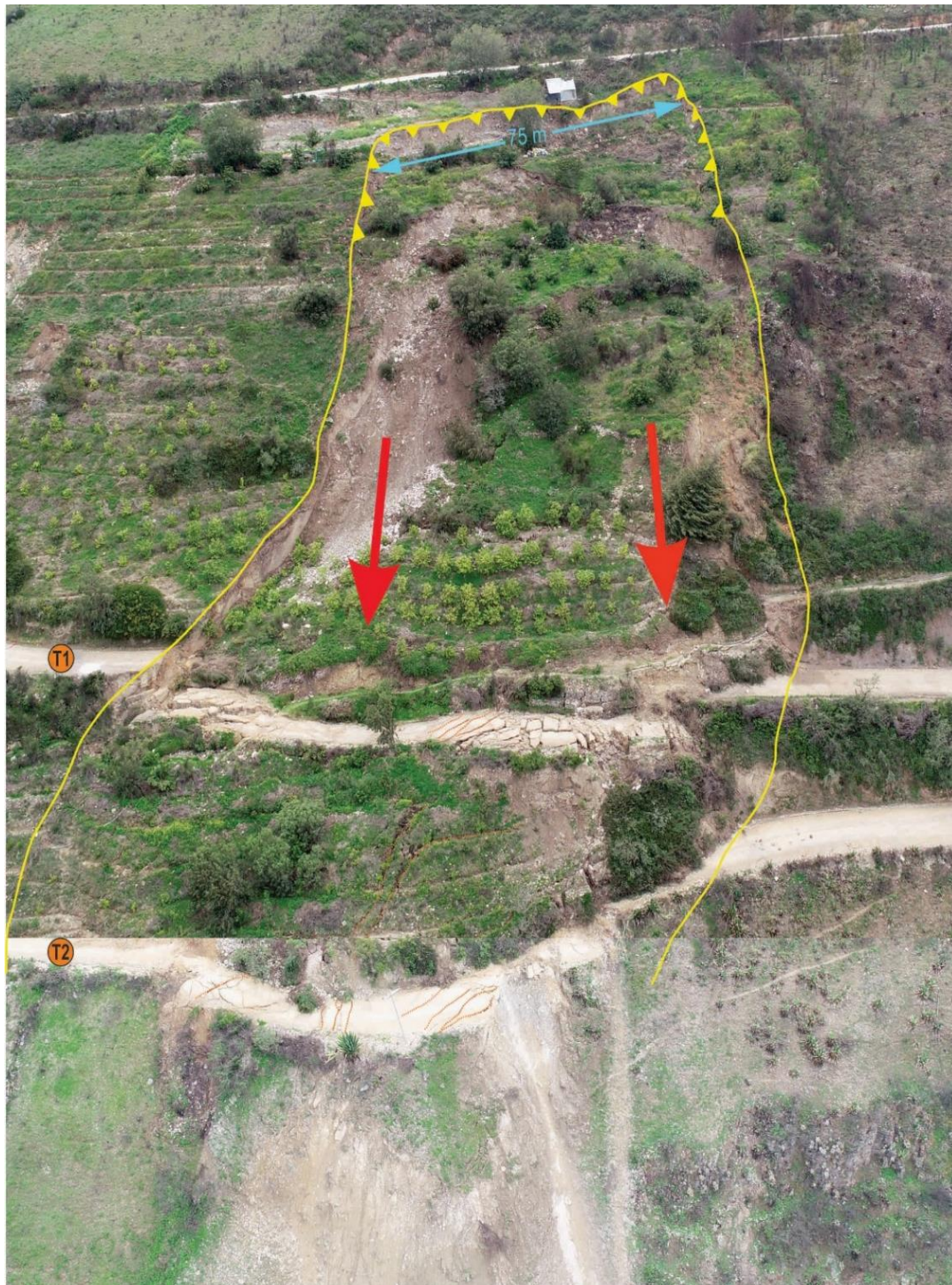
Figura 14. Vista frontal del deslizamiento rotacional, que afecto dos tramos de la carretera de Shancayan a Pumarranra, actualmente se interrumpió el tránsito vehicular.
