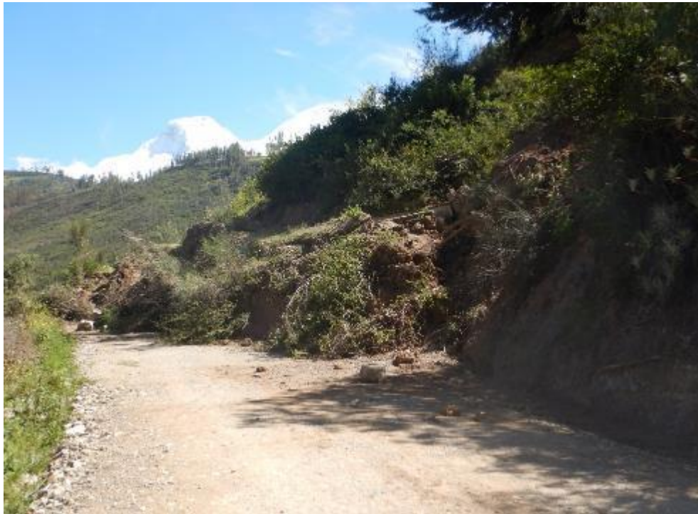
Fotografía 3. Se observa que el tramo T2, esta obstaculizado con el material del deslizamiento, el mismo que está compuesto de areniscas y lutitas, cubierto por vegetación.
