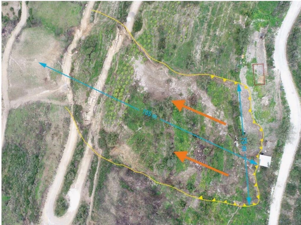
Figura 11. Vista del deslizamiento de Shancayan, tomada con el dron; donde se observa las dimensiones de la escarpa principal.
