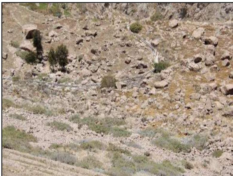
**Figura 10.** Se evidencia bloques caídos sobre la zona agrícola de Coraguaya, (coordenadas UTM E: 348114, N: 8089274).
