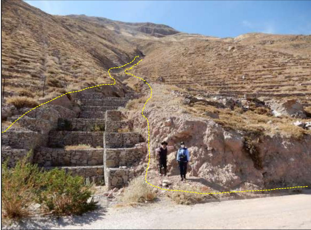
**Figura 24.** Diques transversales y canalización de cauce con muros laterales escalonados de gaviones en la Quebrada Lloctata, (coordenadas UTM E: 346633, N: 8084886)
