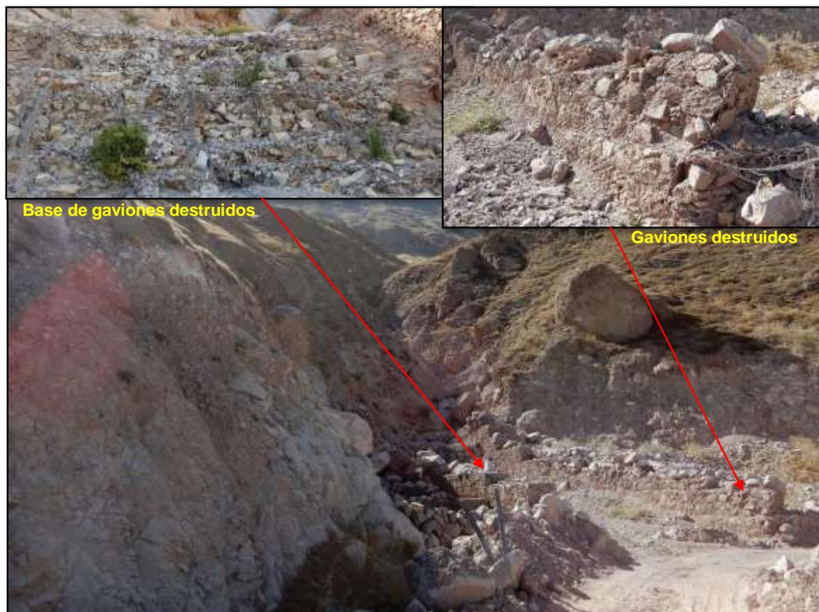
**Figura 25.** Gaviones escalonados destruidos en ambas márgenes de la quebrada Tampuni, (coordenadas UTM E: 346524, N: 8084687)
