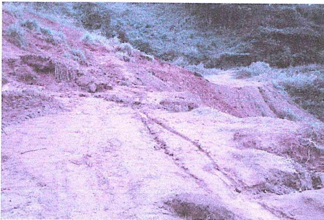
Canal Perlamayo en el Tramo 7+000 - 7+140 con los derrumbes de la ladera saturada por las intensas lluvias y las filtraciones
