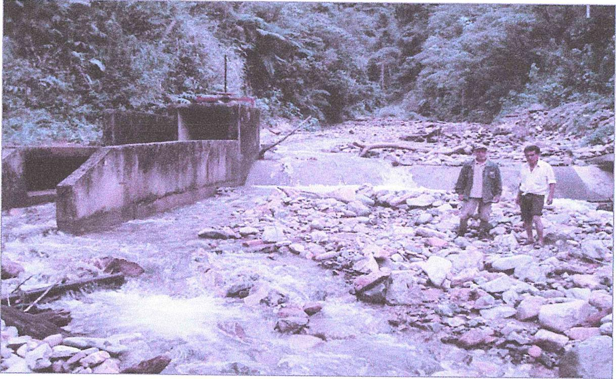
**Fotografía N°01: Bocatoma Perlamayo colmatada con material de acarreo de la quebrada Perlamayo por efecto de las máximas avenidas presentadas en respuesta a las intensas lluvias en la cuenca.**
