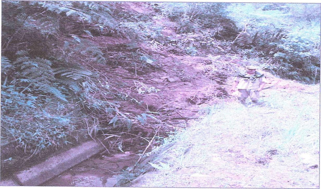
**Fotografía N°02: Canal Perlamayo en el tramo 1+535 – 1+595 con los derrumbes en la caja hidráulica y camino de servicio, como resultado de las fuertes precipitaciones pluviales en ladera muy susceptible a los deslizamientos.**
