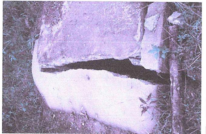
Conducto cubierto de concreto armado del Canal Perlamayo en el Tramo 7+000 - 7+140, afectado por los deslizamientos de la ladera.
