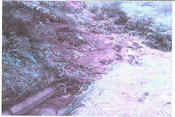
Canal Perlamayo en el tramo 1+535 - 1+595 con los derrumbes en la caja hidráulica y camino de servicio, como resultado de las fuertes precipitaciones pluviales en ladera muy susceptible a los deslizamientos.
