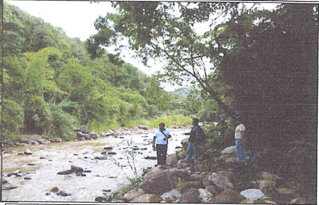
Colmatación y deposición de material de acarreo de la quebrada en el canal San José
