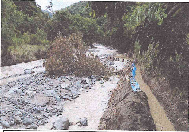
Erosión de riberas y colmatación de cauce de las quebradas de derivación (Canal El Pistolero)
