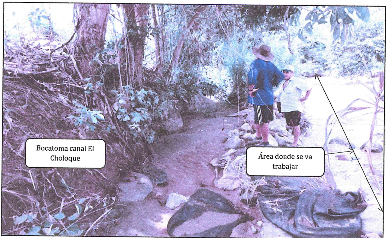
Fotografía N° 06: Erosión de riberas y colmatación de cauce de las quebradas de derivación (Canal El Choloque).
