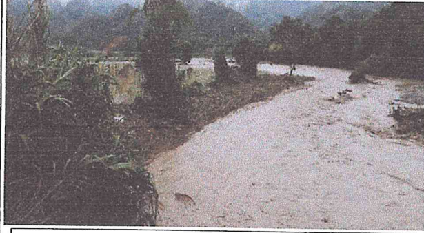
Erosión de riberas y colmatación de cauce de las quebradas de derivación (Canal El Choloque).
