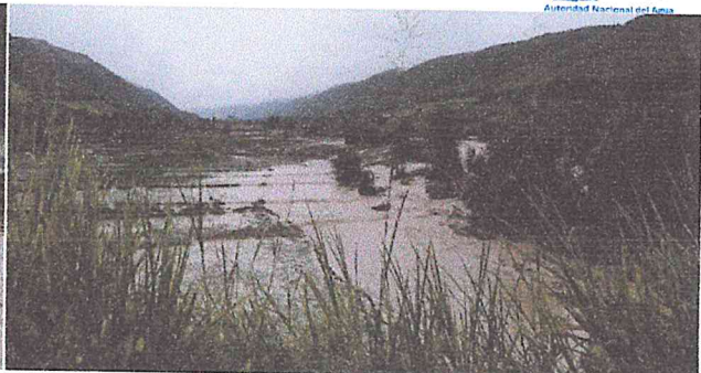
Erosión de riberas y colmatación de cauce de las quebradas de derivación (Canal Cereza).
