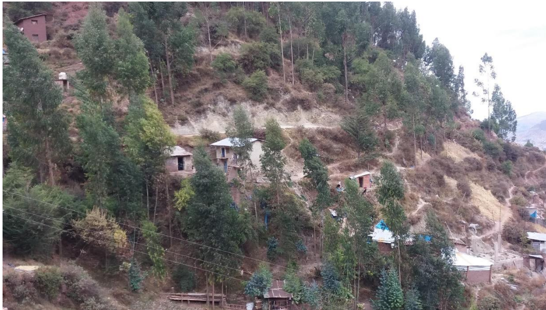
Fotografía 10: Ladera de quebrada con pendiente fuertemente empinada
