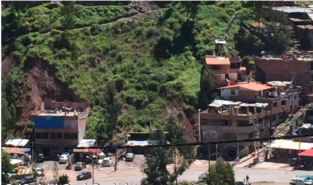
Fotografía 13: Pendiente llano a inclinado ubicada en la plataforma donde se encuentran viviendas asentadas y la vía asfaltada Cusco Abancay
