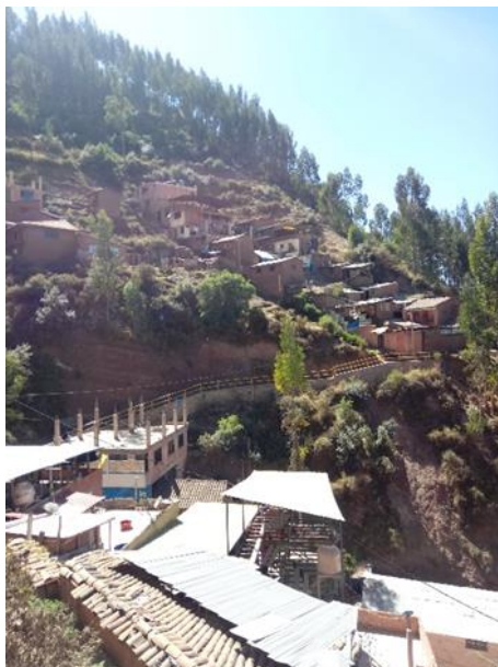
Fotografía 15: Ladera fuertemente empinada parte de la ladera de quebrada.
