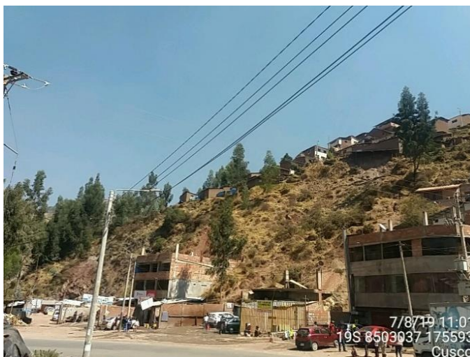
Fotografía 18: Terraza antrópica donde se asentaron las viviendas como la infraestructura vial.
