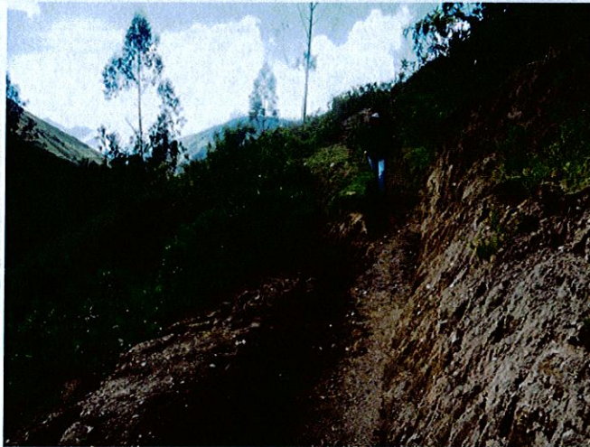
Foto 4: Canal de drenaje afectado por reactivación de deslizamiento de 1985.
