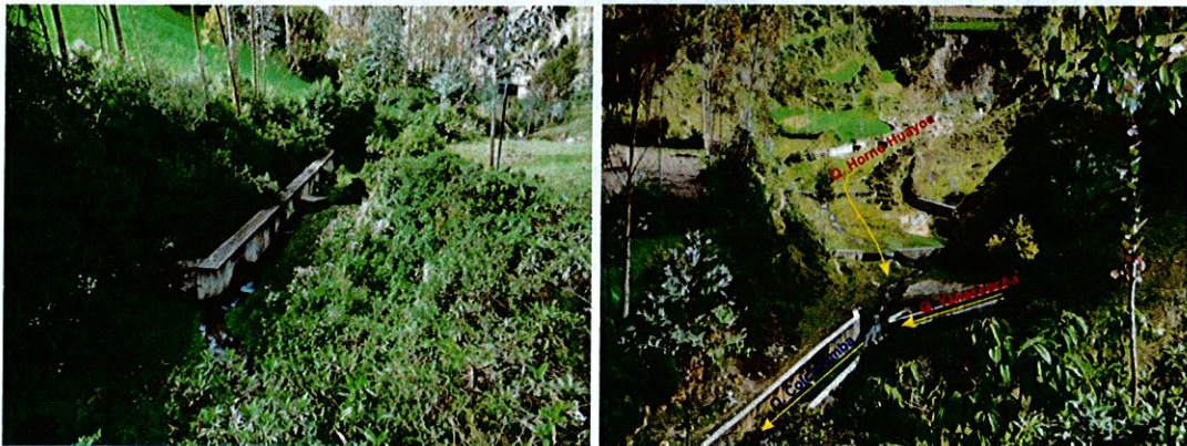
Foto 23 y 24: Obras de encausamiento con muros de concreto y diques transversales a los cauces, en la quebrada Colcabamba y sus tributarios (quebradas Horno Huayoc y Yanaccocha).
