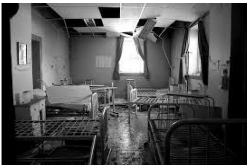
**Figura 10.** Luminarias no sujetadas adecuadamente en techo ante movimientos sísmos
