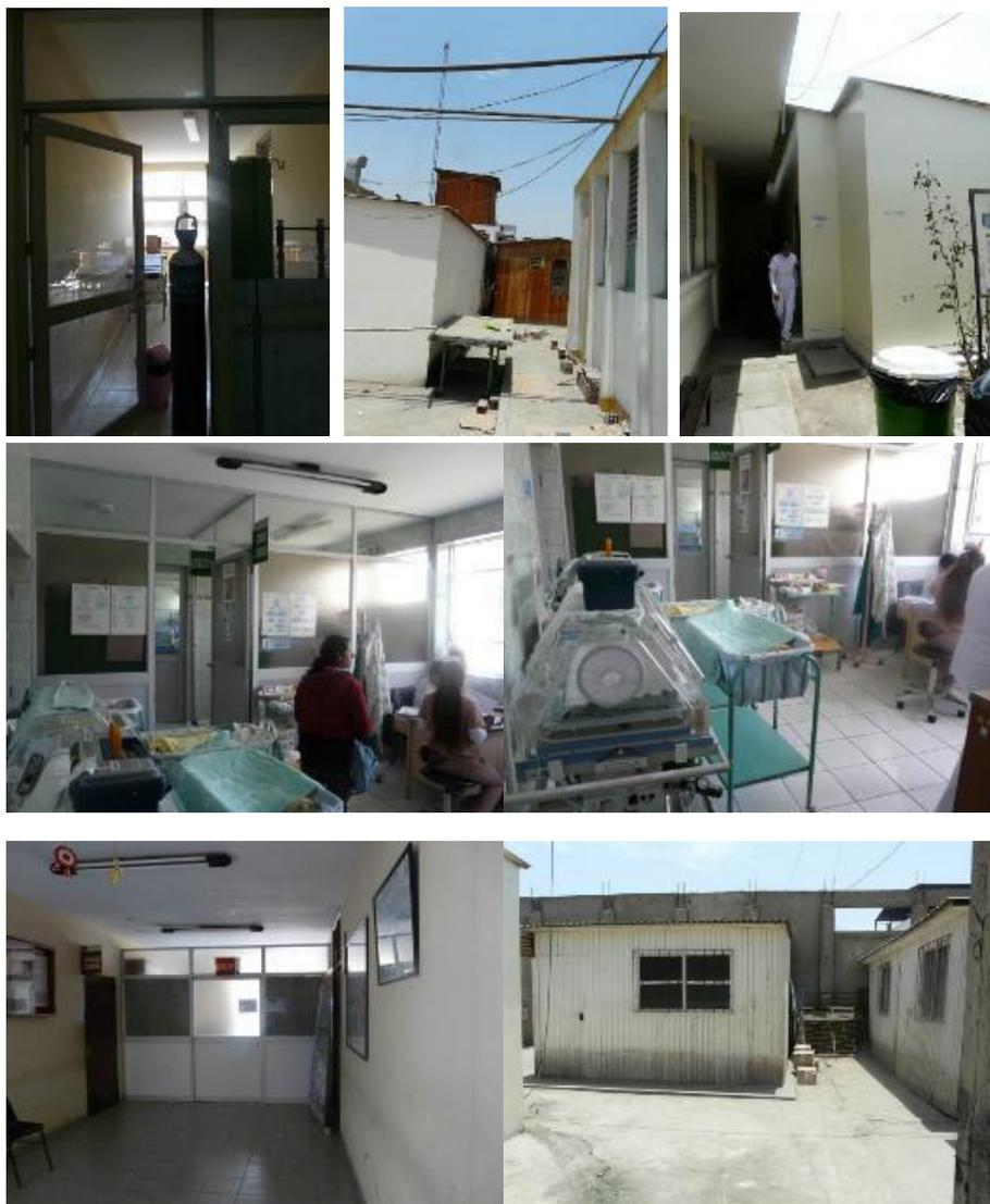
Debido a lo anterior, y a que la estructura no se encuentra debidamente rigidizada para restringir las deformaciones laterales y la distorsión angular de los vanos en los cuales se encuentran los tabiques, es de esperarse que en caso de un sismo moderado o intenso se rompan un número importante de vidrios por el daño o deformación de los marcos de las ventanas.
