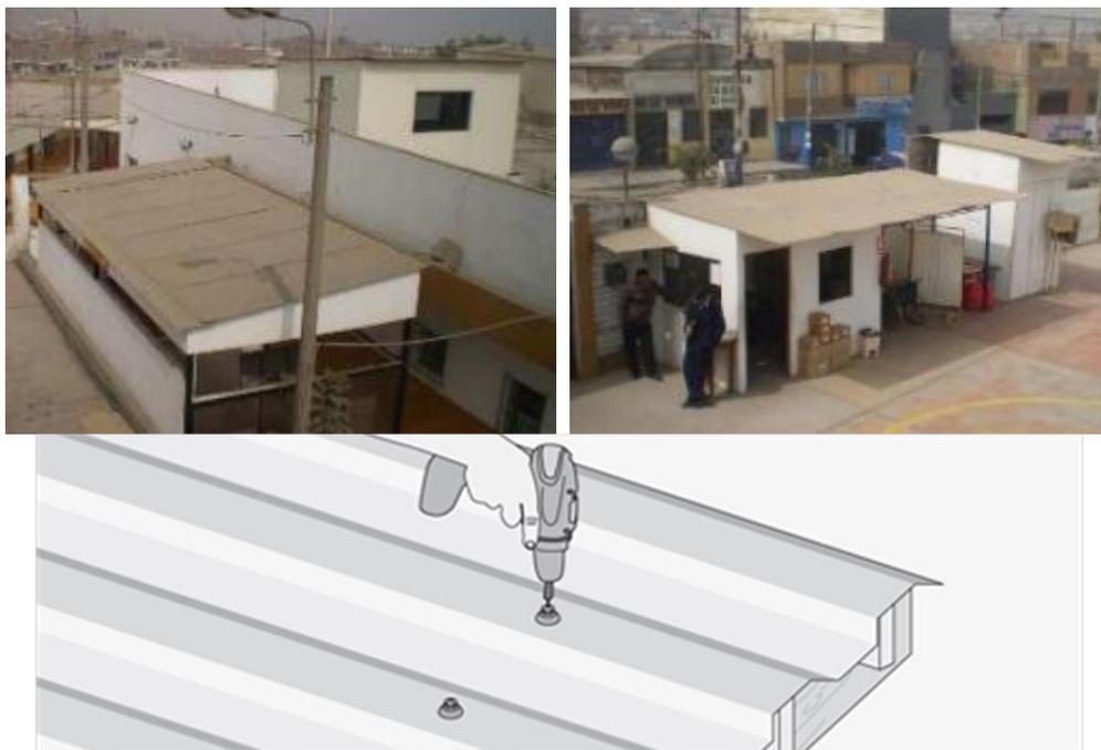
**Figura 7.** Techos ligeros que deben estar sujetos adecuadamente a fin evitar caídas o desprendimientos
