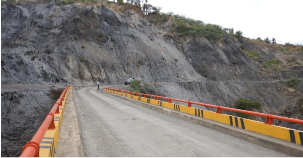
Fotografía 1: Vista del pie del deslizamiento en la margen izquierda del río Pomabamba, muestra una capa de arcillas negras altamente plásticas y cohesivas.
