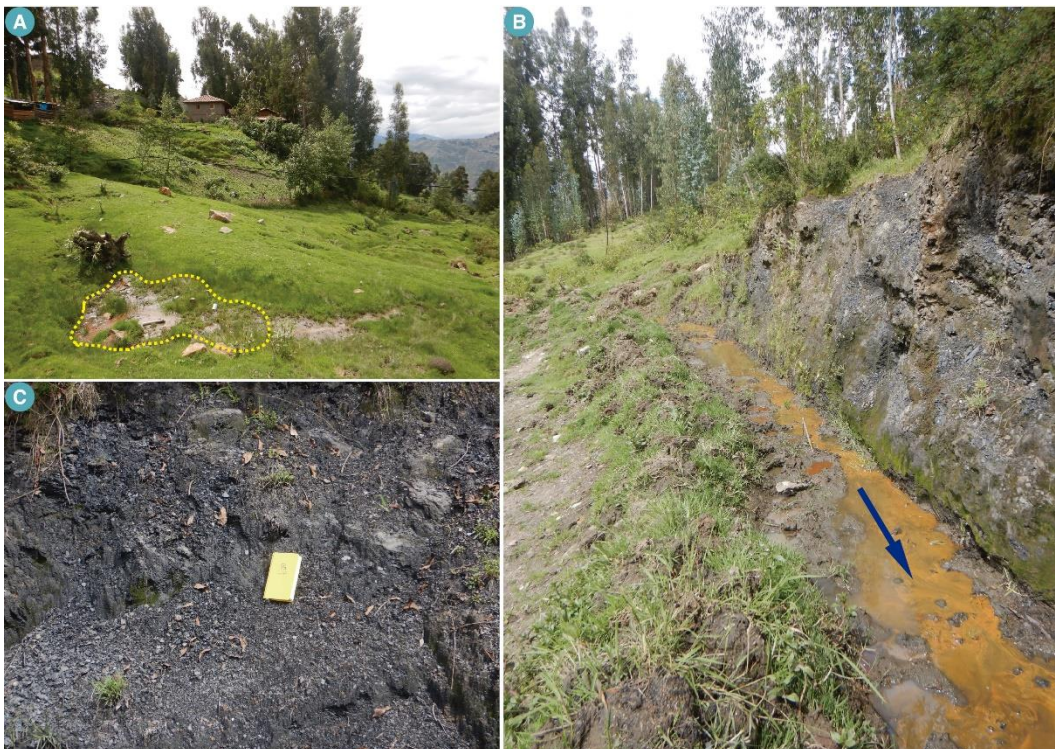
Figura 12: A: Muestra ojos de agua cercanos al punto de inspección 2. B: Se aprecia canales de riego no impermeabilizados. C: Afloramiento de arcillas pizarrosas altamente saturadas.
