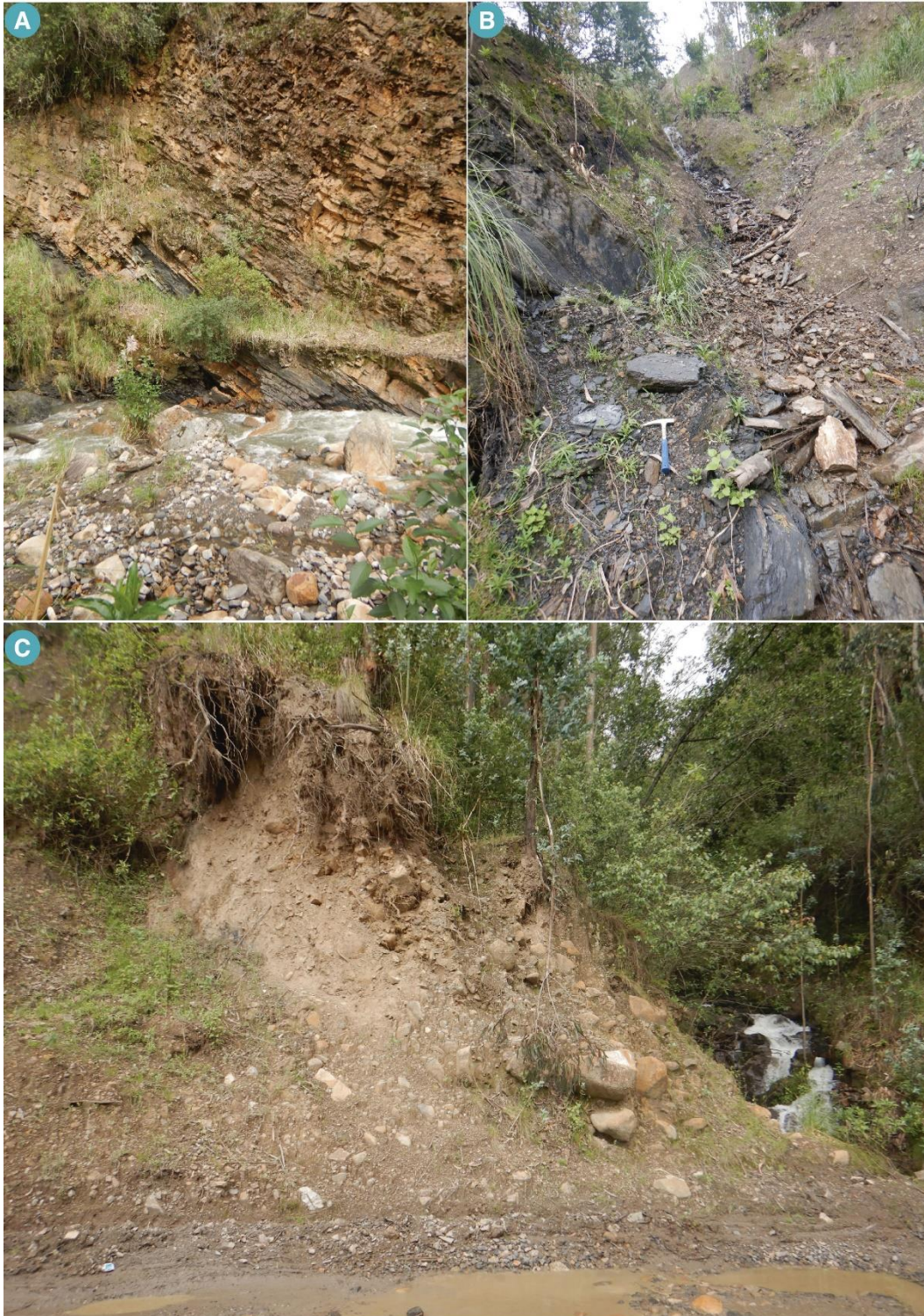
Figura 9: A) Muestra afloramientos de pizarras foliadas y fracturadas de la Formación Chicama, B) Muestra el material proluvial de la quebrada Chipre. C) Muestra los depósitos coluvio-deluviales que generan derrumbes en el punto de inspección 1.
