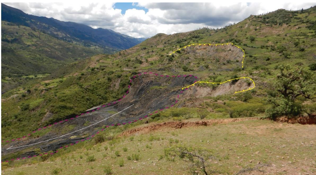
Figura 23: Muestra escarpes principales de 10m de altura del deslizamiento activo, y la zona de flujo de detritos que llega hasta el río Pomabamba.
