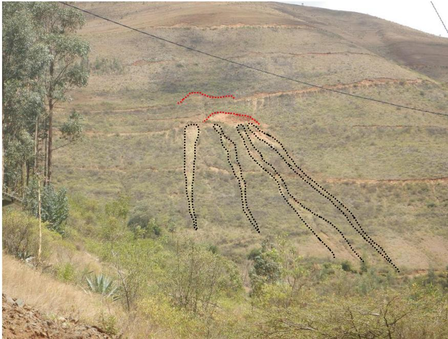
**Figura 13.** Procesos de erosión de laderas tipo surcos y cárcavas (línea punteada negra) y derrumbes (línea punteada roja) en la vía de acceso a la Mina Estrella. Coordenadas UTM WGS84: 244622E; 9093120N.
