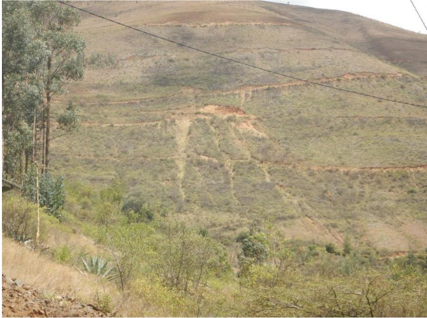
**Fotografía 5.** Vía de acceso hacia la Mina Estrella, la cual se encuentra afectada por derrumbes recientes y procesos de erosión de laderas a manera de cárcavas. Coordenadas UTM WGS84: 244622E; 9093120N.
