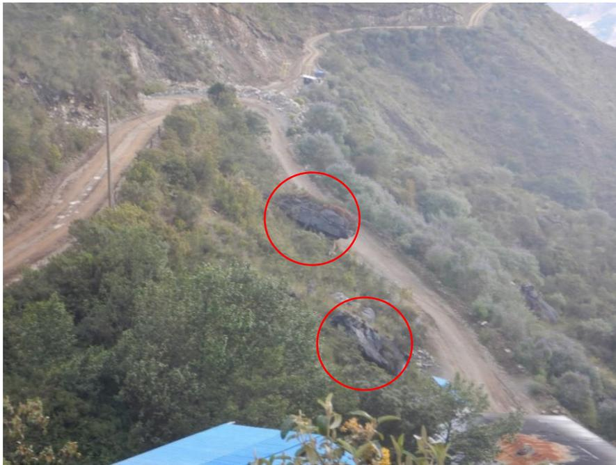
**Figura 12.** Caída de rocas identificados en la Mina Estrella, con bloques de hasta 5 metros de diámetro. Coordenadas UTM WGS84: 245974E; 9095330N.
