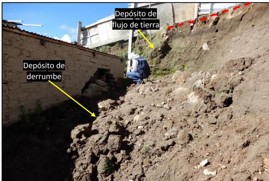
**Figura 12.** Vivienda afectada por derrumbe a causa de corte realizado en el cuerpo del depósito de flujo de tierra. (coordenadas UTM E: 792866, N: 8335313).
