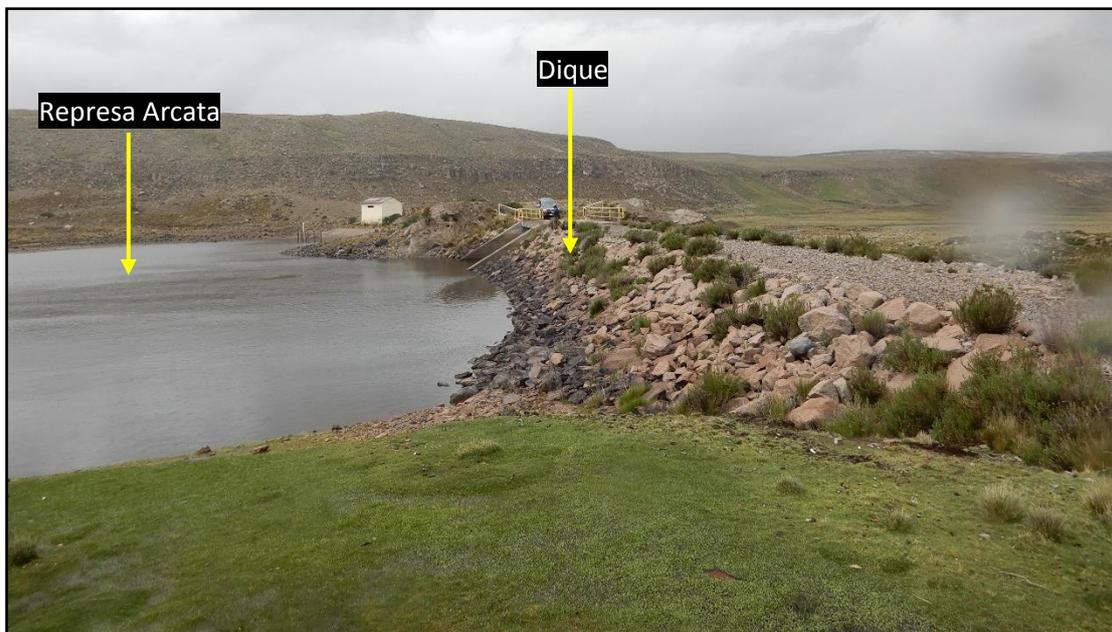
**Figura 21.** Dique de la represa Arcata. (coordenadas UTM E: 791811, N: 8333534).
