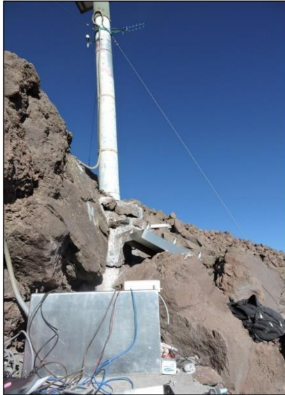
Figura 2.3. Estación MST01, ubicada en el flanco sur del volcán Misti.
