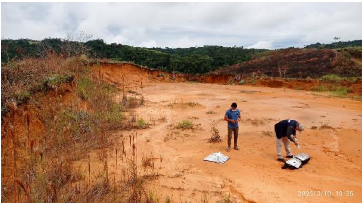
Fotografía 7. Corte en el terreno que muestra espesores de hasta 3.00 m de depósitos deluviales areno arcillosos de coloraciones rojizas a naranjas, debido a la presencia de óxidos.
