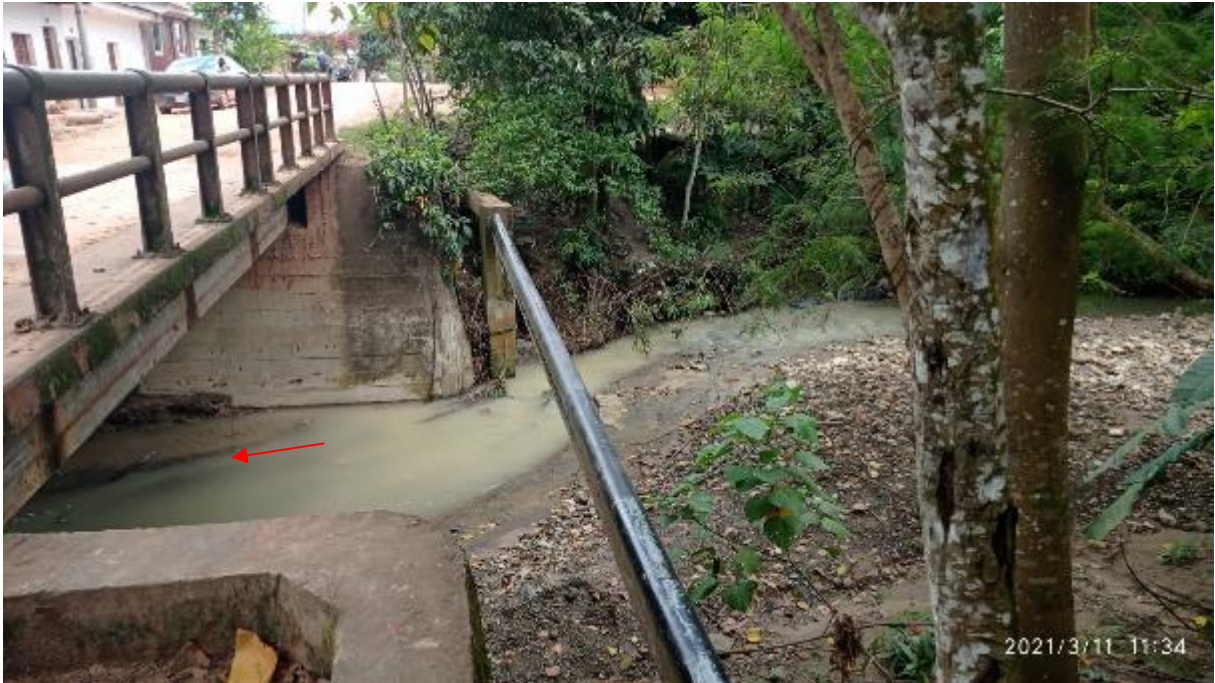
Figura 13. Quebrada Upianillo, altura del Puente Upianillo.
