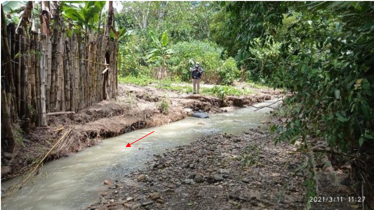
Figura 12. Quebrada Upianillo (E365281 - N9260702).
