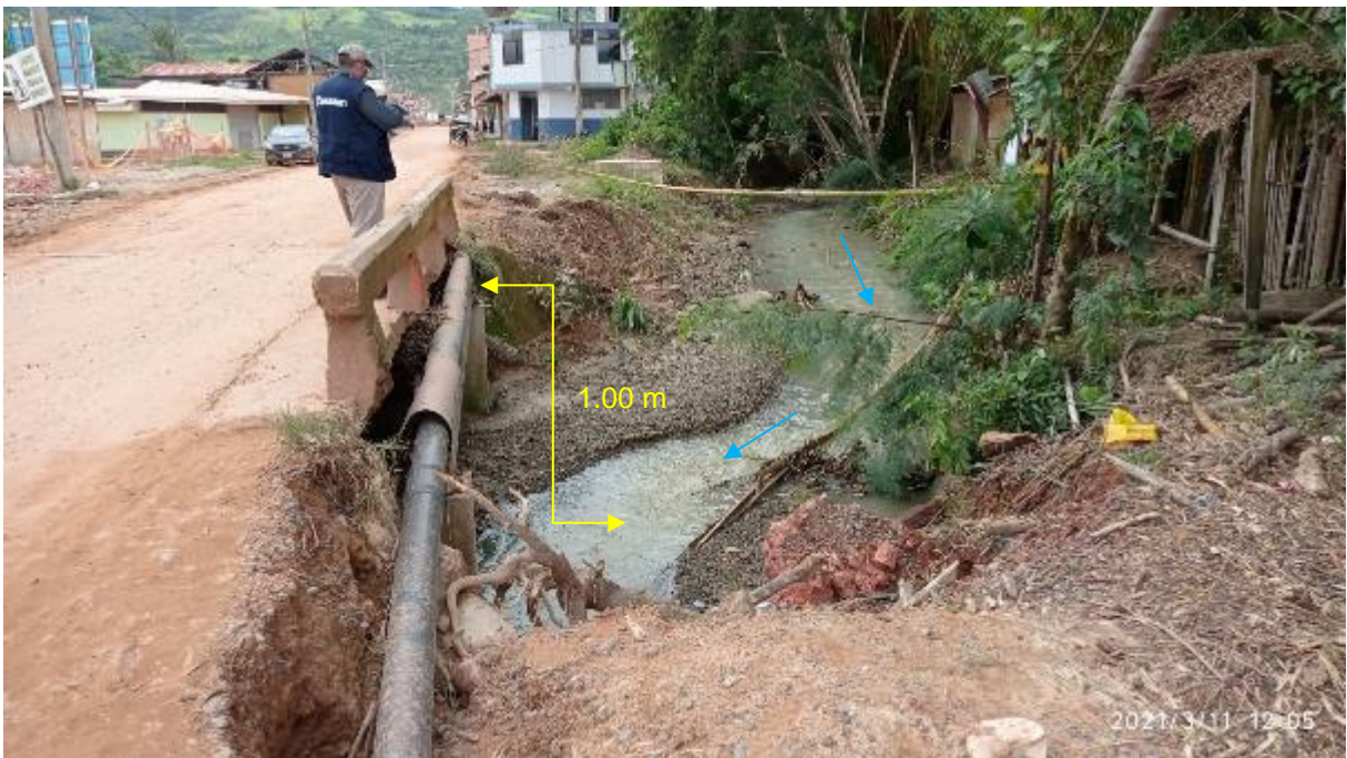
Figura 16. Vista hacia aguas arriba, del pontón ubicado en la Av. Leticia. Nótese el reducido espacio entre la plataforma y el cauce activo de la quebrada Upianillo.
