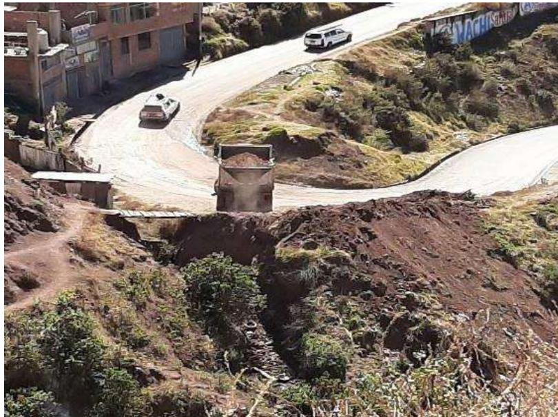
Fotografía 8: Evidencia de material de relleno, en plena cárcava, Vista al NE tomada del frente en la zona de estudio
