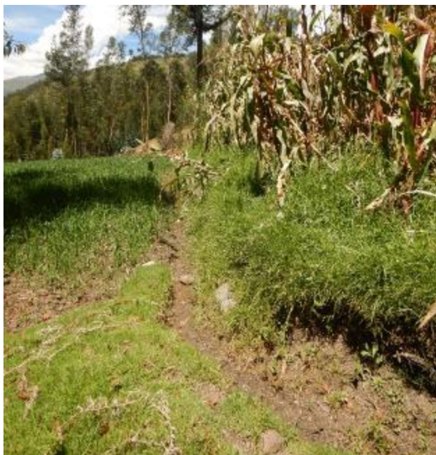
Fotografía 2. Canal de regadío sin revestimiento, el que se encuentra próximo a las viviendas afectadas, actualmente no está discurriendo agua por el evento generado, se ubica en 8975262 N, 212171 E con una altitud de 2955 m s.n.m.
