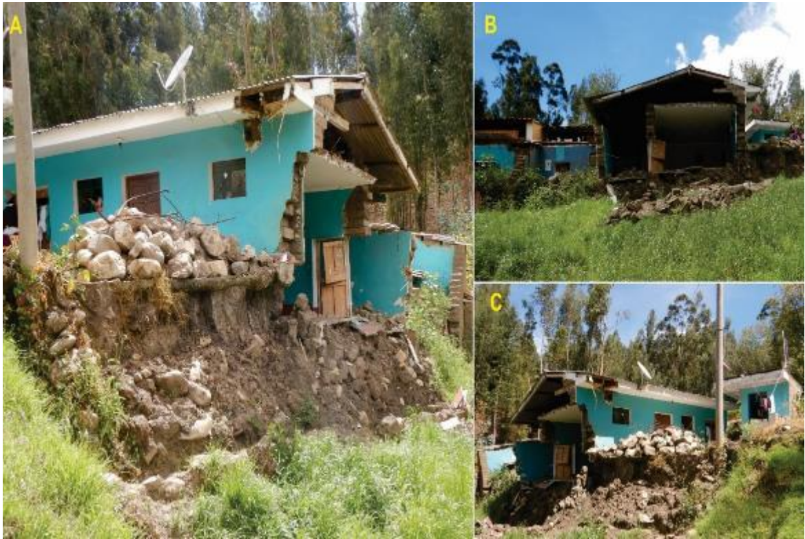
Figura 15. Vista hacia el noroeste, donde se observa parte de la vivienda destruida, así como un poste de tendido eléctrico que podría caer. La vivienda presenta grietas en las paredes y piso; actualmente, esta sigue siendo habitando en algunos ambientes que no fueron afectados, lo cual se considera peligroso.
