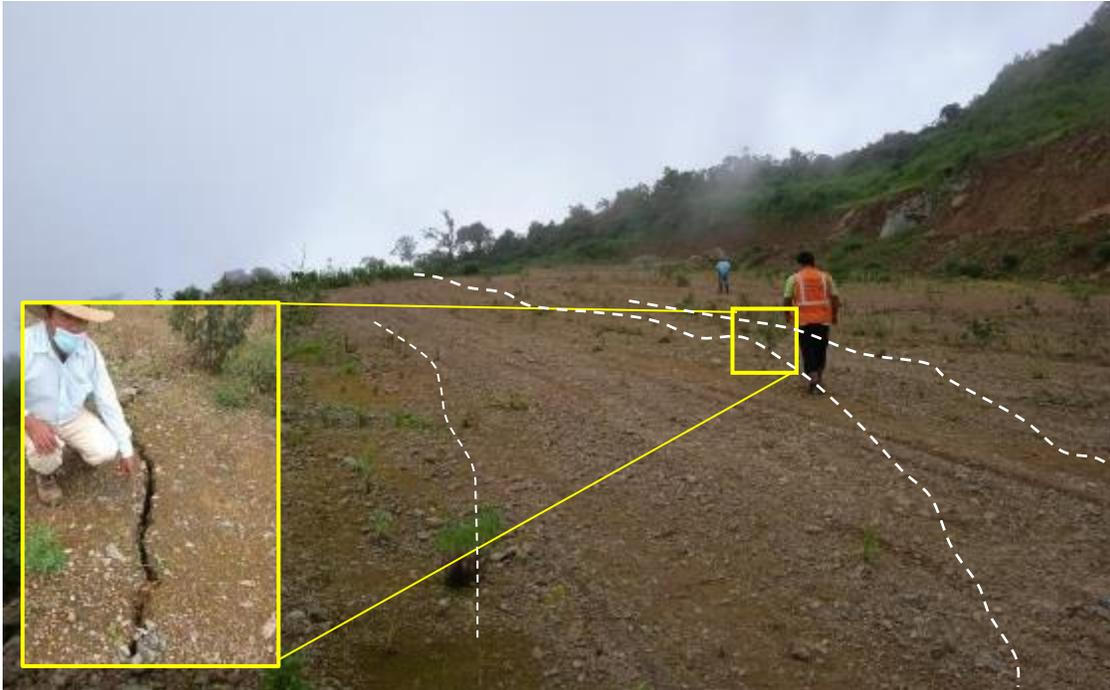
**Figura 57.** Vista de los agrietamientos observados en el DME-07.
