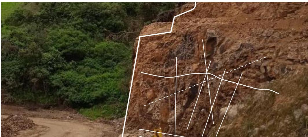
**Figura 47.** Afloramiento de andesitas y piroclastos muy fracturados.
