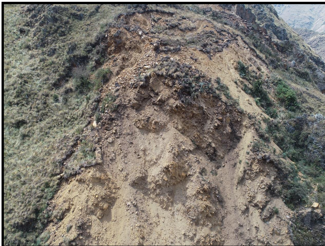
Imagen N° 22: Evidencia de agrietamiento en el cerro Tartayocc, próximo al colapso y deslizamiento de grandes masas de volumen.
