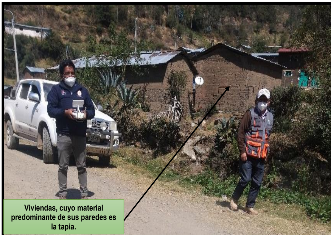
Imagen N° 23: Vista de las viviendas, cuyo material predominante de sus paredes es el tapial, material que es frágil ante la ocurrencia del fenómenos por flujo de detritos.
