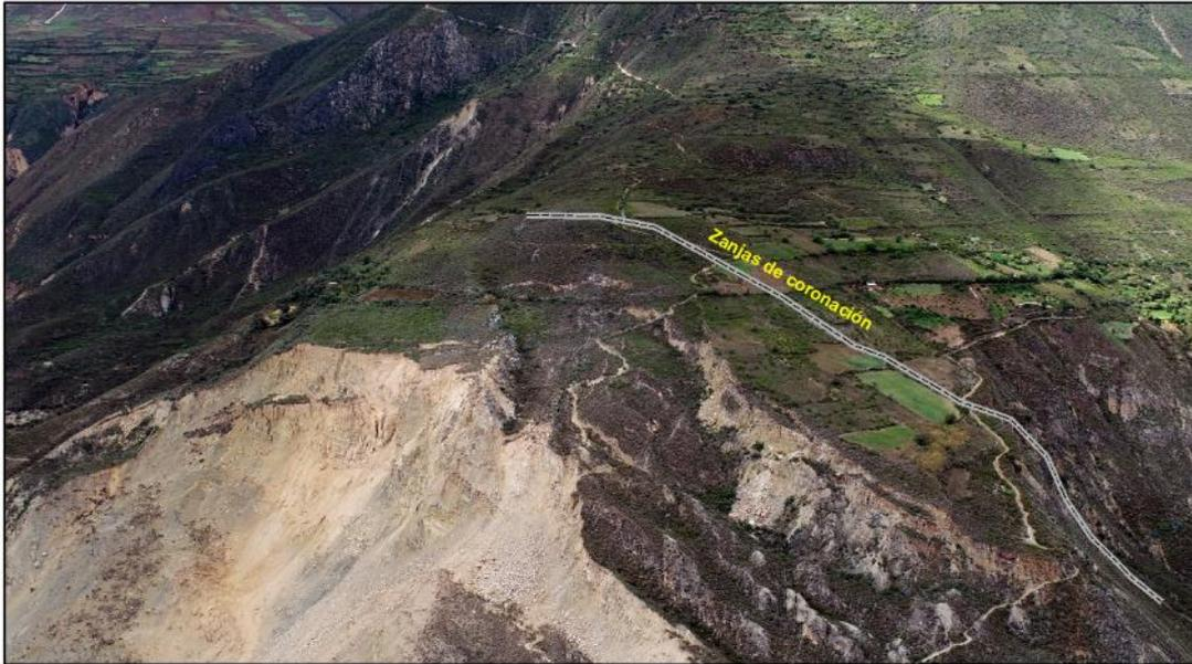
**Figura 19.** Zanjas de coronación se debe ubicar en la parte superior del escarpe antiguo
