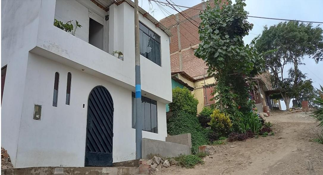
FOTOGRAFÍA N°3. Mz. C20, Lote 10 vivienda con material de ladrillo y cemento con cimientado de cemento y estado bueno de construcción.
