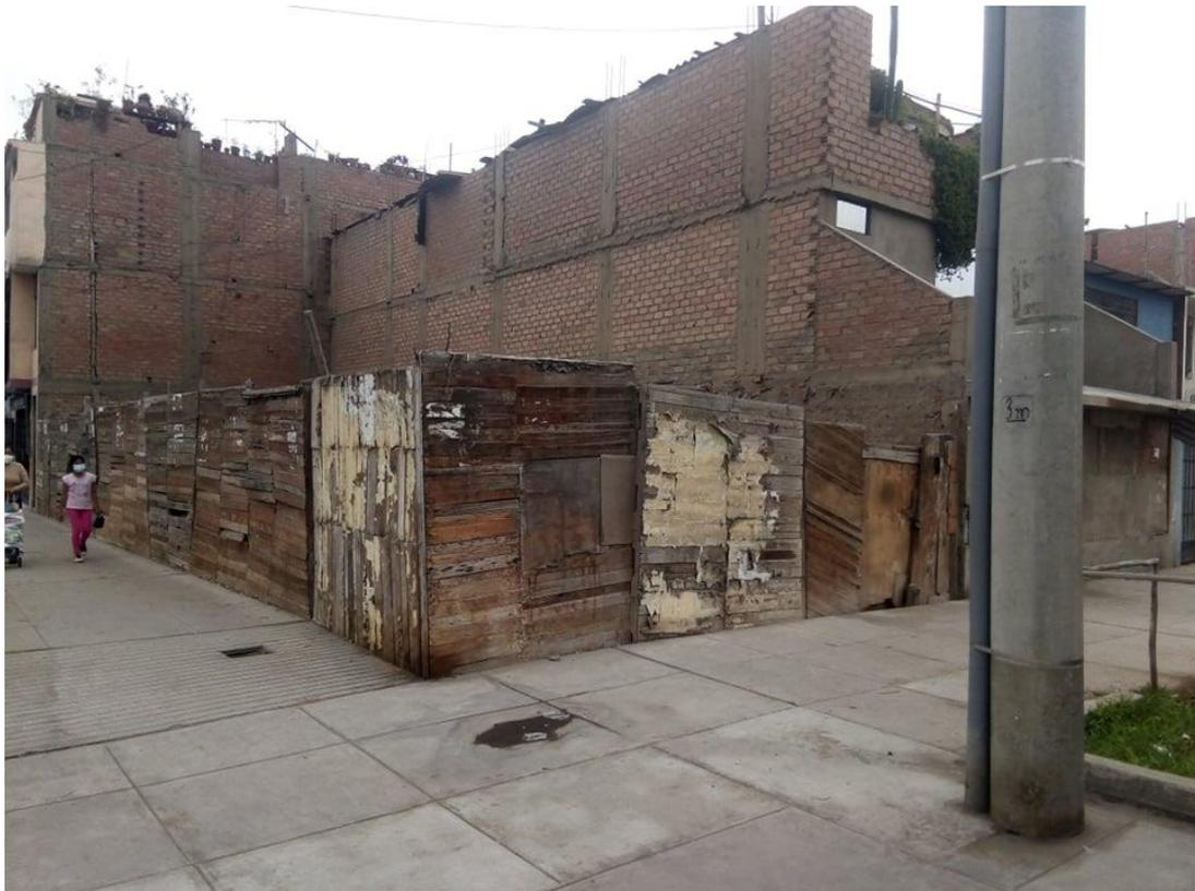
FOTOGRAFÍA N°16. Mz. C12, lote 1 con fachada de madera y en un mal estado.
