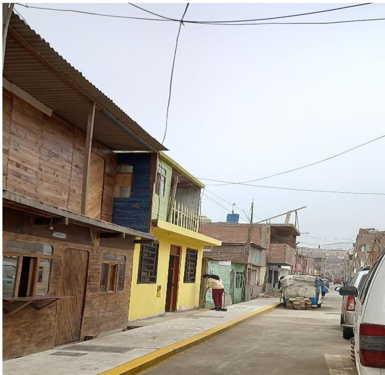
FOTOGRAFÍA N°1. MZ. L, lote 31 vivienda de material de madera, cimiento de concreto y se encuentra en buen estado.
