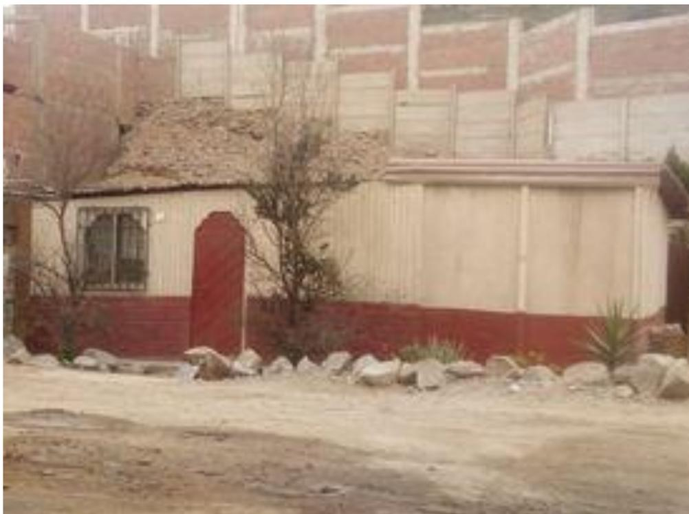
FOTOGRAFÍA N°18. Mz. C12A, lote 1 vivienda de material de madera, cimient de cemento en estado regular.
