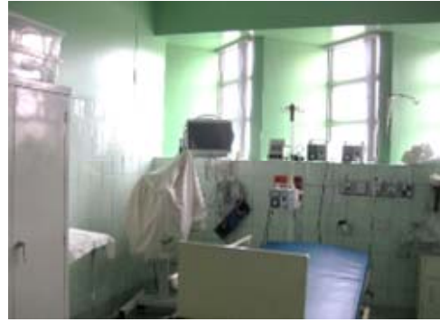
Figura 129: En el bloque C en algunos casos el equipo médico se encuentra bien sujeto y anclado a la pared; sin embargo, hay otros que se encuentran solamente colocados sobre el muro bajo tendiendo a un posible desplazamiento ante cualquier eventualidad.
