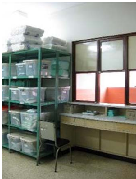
Figura 109: En el bloque C en Esterilización, existe muebles y estanterías no fijados a muros o techos, además su contenido no están asegurados tienden al volcamiento en casos eventuales y al desplazamiento de objetos ubicados en la parte superior de éstos.
