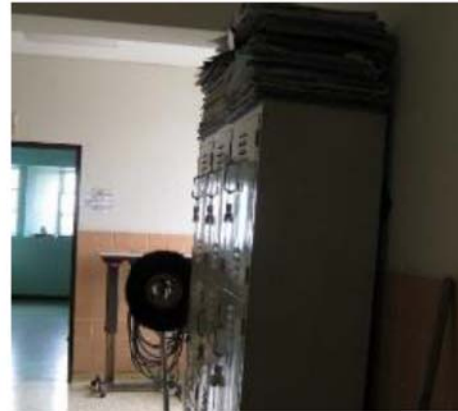
Figura 111: En el bloque D los casilleros no fijados a la pared, piso o techo, tienden al volcamiento en casos eventuales. Otro factor, es el desplazamiento de objetos ubicados en la parte superior de éstos.
