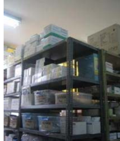
Figura 105: Izquierda: En el bloque J los equipos y estantes no están fijados. Derecha: en el bloque J en el almacén de farmacia los contenidos de las estanterías no están asegurados a techos o paredes, y estas pueden caer ante un movimiento.
