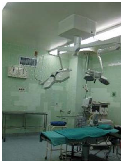
Figura 119: En el bloque C en la Sala de Operaciones con mobiliario y Equipos rodables en regular estado, Cialitica sujetado en techo en buen estado, los cables de equipos no están debidamente canalizados.
