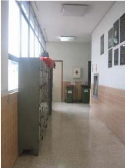
Figura 107: Izquierda: en el bloque D los casilleros no están asegurados hay riesgo de volcadura.
