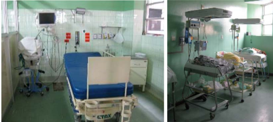
Figura 141: En el bloque C y D, en UCI, Obstetricia Neonatología los equipos rodantes, como camillas, incubadoras, equipos de monitoreo, se encuentran en buen estado. Además, cuentan con un sistema de frenos asegurados para evitar su desplazamiento ante cualquier eventualidad y evitar riesgos.
