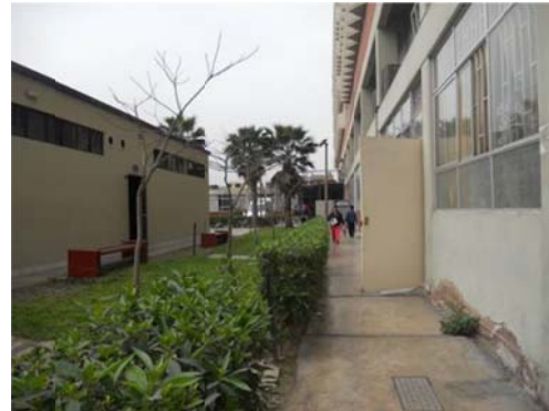
Figura 20. Una vez bordeado el pasillo se puede divisar el patio de ambulancias de Emergencia.
