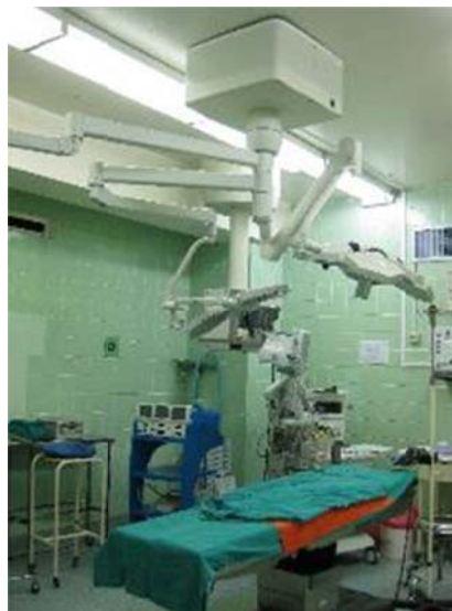
Figura 119: En el bloque C en la Sala de Operaciones con mobiliario y Equipos rodables en regular estado, Cialitica sujetado en techo en buen estado, los cables de equipos no están debidamente canalizados.
