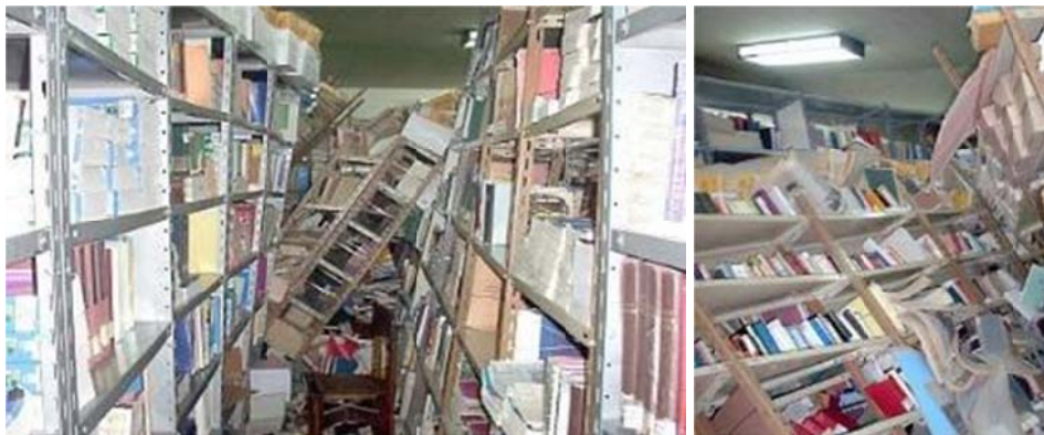
Figura 15 Caída y volcamientos de estanterías que no están adecuadamente sujetos.
