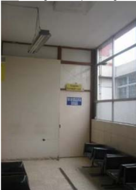
Figura 106: Izquierda. Las luminarias no están aseguradas en el bloque K corredores con mobiliario usados como espera reduciendo circulación. Derecha: En el bloque K las estanterías arriastradas entre sí en la parte superior. Sin embargo, los contenidos no se encuentran asegurados y tienden al desplazamiento de éstos.
