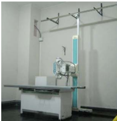
Figura 128: En el bloque K los equipos médicos se encuentran anclados tanto al a la pared de manera no adecuada, aunque en la bases si están sujetas debidamente.
