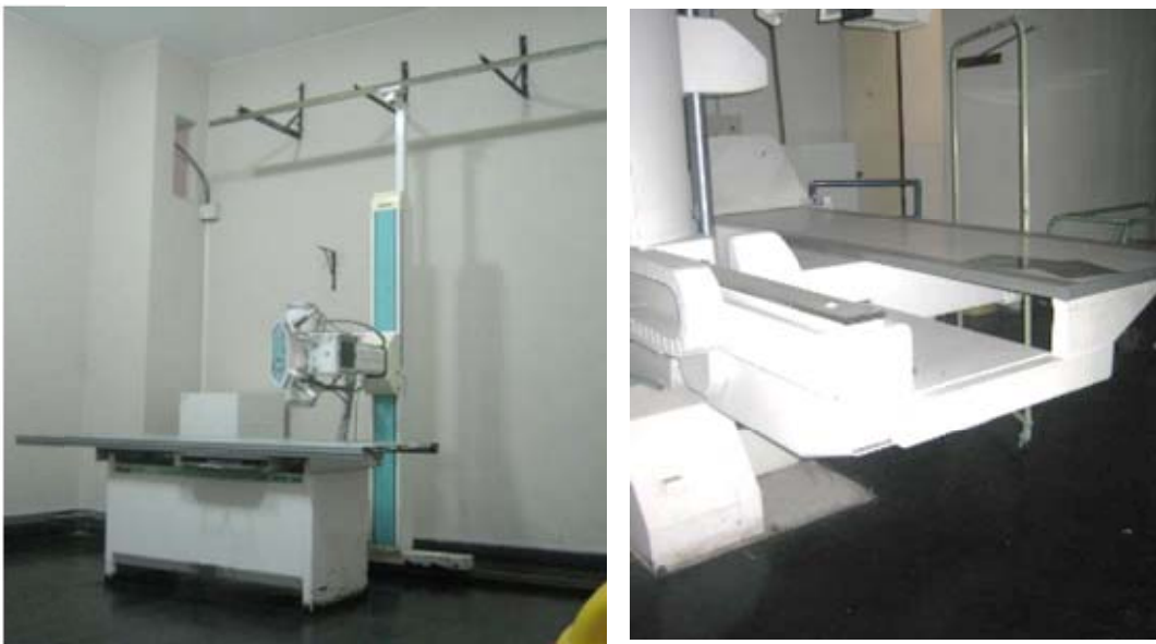
Figura 145: En el bloque K en los ambientes de Rayos X(Primer Piso) los equipos médicos se encuentran en buen estado y fijados al piso y otros sujetos a unas barras metálicas y en L a la pared.
