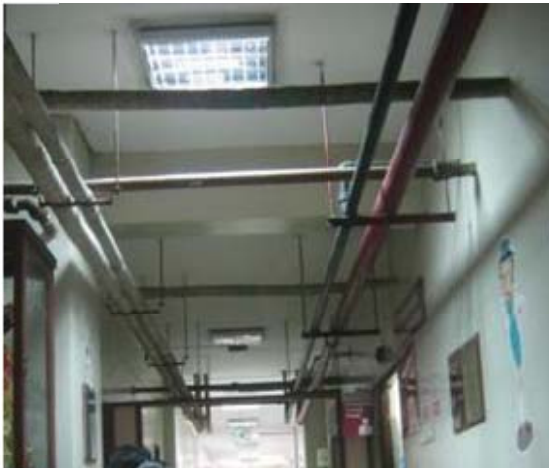
Figura 149: Izquierda: En el bloque A en Emergencia (Primer Piso) se encuentran las tuberías de agua suspendidas del techo en los corredores, no cuentan con falso cielo raso en estas zonas críticas Derecha: En el bloque C en UCI (Segundo Piso) se tienen varillas metálicas suspendidas del techo para la colocación de cortinas para separar los ambientes de una camilla y otra, se debe verificar sujeción
