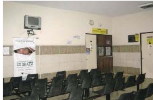
Figura 100: Izquierda: En el bloque I las conexiones de los cables se encuentran expuestas. Derecha: Televisor sujetado con rack en la sala de espera es frágil ante un sismo.
