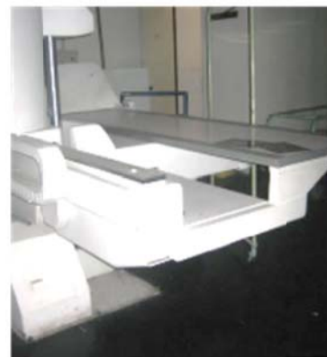
Figura 128: En el bloque K los equipos médicos se encuentran anclados tanto al a la pared de manera no adecuada, aunque en la bases si están sujetas debidamente.
