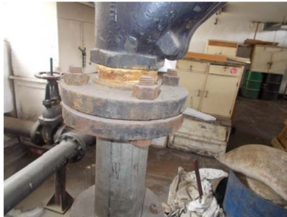
Figura 159. Tubería de F°G° reemplazada en línea de impulsión
