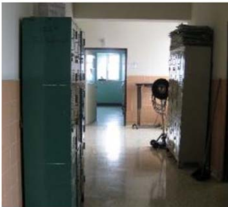
Figura 111: En el bloque D los casilleros no fijados a la pared, piso o techo, tienden al volcamiento en casos eventuales. Otro factor, es el desplazamiento de objetos ubicados en la parte superior de éstos.
