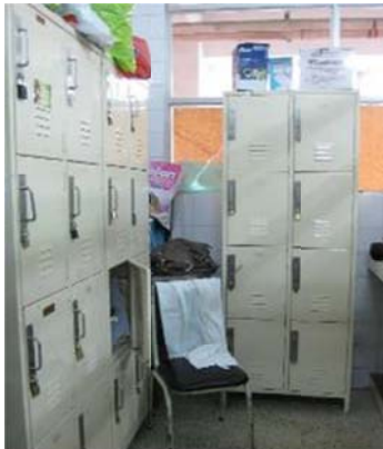
Figura 108: En el bloque C los casilleros no fijados a la pared, piso o techo, tienden al volcamiento en casos eventuales. Otro factor, es el desplazamiento de objetos ubicados en la parte superior de éstos.
