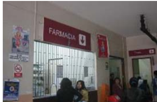
Figura 101: En el bloque D, el hall de Emergencia de espacio reducido, en zona de caja se aprecia vidrio que no es de seguridad corre riesgo de rotura ante deformaciones, se observa que las instalaciones sanitarias se encuentran expuestas y, en general, las luminarias se encuentran protegidas.
