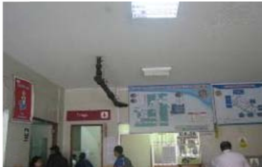
Figura 101: En el bloque D, el hall de Emergencia de espacio reducido, en zona de caja se aprecia vidrio que no es de seguridad corre riesgo de rotura ante deformaciones, se observa que las instalaciones sanitarias se encuentran expuestas y, en general, las luminarias se encuentran protegidas.
