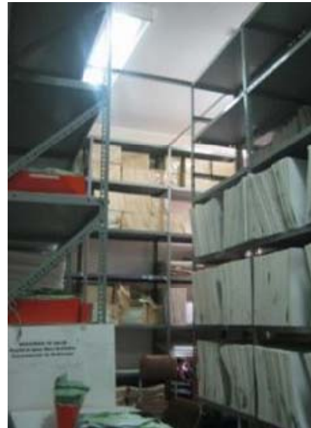
Figura 106: Izquierda. Las luminarias no están aseguradas en el bloque K corredores con mobiliario usados como espera reduciendo circulación. Derecha: En el bloque K las estanterías arriastradas entre sí en la parte superior. Sin embargo, los contenidos no se encuentran asegurados y tienden al desplazamiento de éstos.
