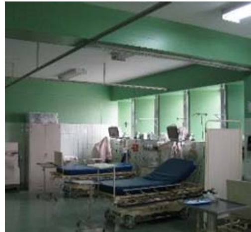
Figura 149: Izquierda: En el bloque A en Emergencia (Primer Piso) se encuentran las tuberías de agua suspendidas del techo en los corredores, no cuentan con falso cielo raso en estas zonas críticas Derecha: En el bloque C en UCI (Segundo Piso) se tienen varillas metálicas suspendidas del techo para la colocación de cortinas para separar los ambientes de una camilla y otra, se debe verificar sujeción
