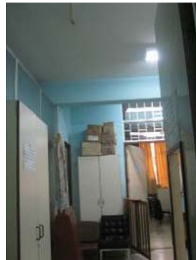
Figura 104: En el bloque C, Armario y estanterías no fijados a pared, piso o techo, tienden al volcamiento en casos eventuales de sismos. Otro factor, es el desplazamiento de los contenidos por no estar asegurados. Asimismo, se aprecia sobrecarga por apilamiento adicional de objetos sobre las estanterías o por cargas que sobrepasan la capacidad máxima del elemento, existe riesgo de caída.
