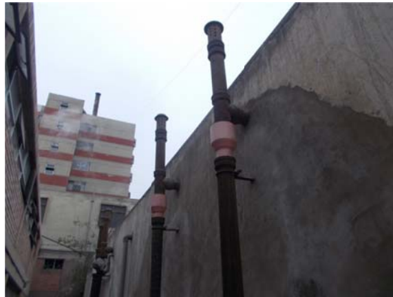
Figura 153. Accesorios de F°F° reemplazadas por PVC
