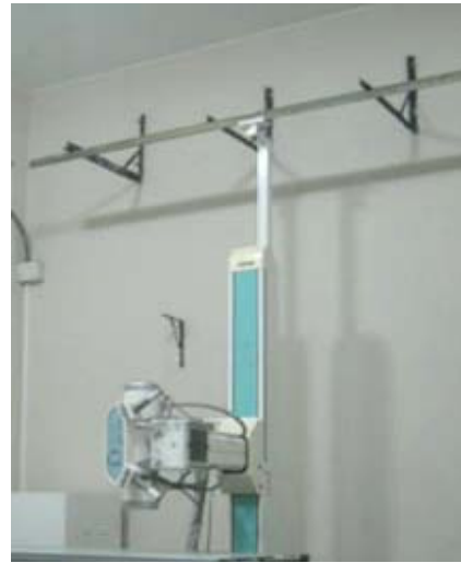
Figura 148: Izquierda: En el bloque C en Centro Quirúrgico (Entrepiso) los equipos médicos están fijados al techo, manteniéndolos suspendidos. (se debe verificar adecuada sujeción) Derecha: En el bloque K en Rayos X(Primer Piso) los equipos médicos están fijados al techo y a la pared.
