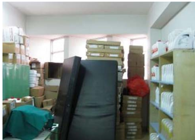
Figura 108: En el bloque C los casilleros no fijados a la pared, piso o techo, tienden al volcamiento en casos eventuales. Otro factor, es el desplazamiento de objetos ubicados en la parte superior de éstos.
