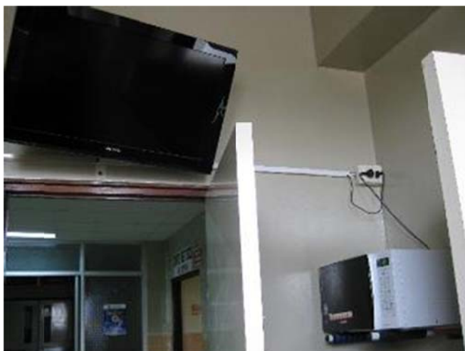
Figura 110: Izquierda: En el bloque D, televisor fijo a la pared, falta de sujeción en la parte inferior. Microondas solamente colocado sobre un elemento, no sujeto a los lados.
