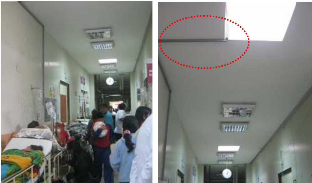
Figura 131: En el bloque A hay presencia de camillas con pacientes que interrumpen la circulación en los corredores. Además, se hace uso de unas canaletas metálicas para los cables de las instalaciones eléctricas.
