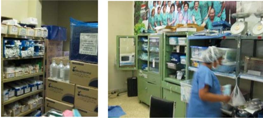
Figura 117: En el bloque C el Armario y estanterías no fijados a pared, piso o techo, tienden al volcamiento en casos eventuales. Otro factor, es el desplazamiento de los materiales médicos por no estar asegurados. Asimismo, se aprecia sobrecarga por apilamiento adicional de objetos sobre las estanterías o por cargas que sobrepasan la capacidad máxima del elemento.
