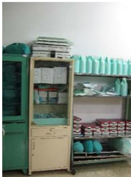
Figura 109: En el bloque C en Esterilización, existe muebles y estanterías no fijados a muros o techos, además su contenido no están asegurados tienden al volcamiento en casos eventuales y al desplazamiento de objetos ubicados en la parte superior de éstos.
