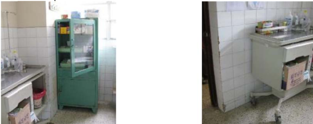
Figura 126: En el bloque D, el equipo médico colocado sobre el techo del armario sin protección o alguna sujeción. Equipo médico bien sujeto con una banda metálica para evitar su desplazamiento o volcamiento.
