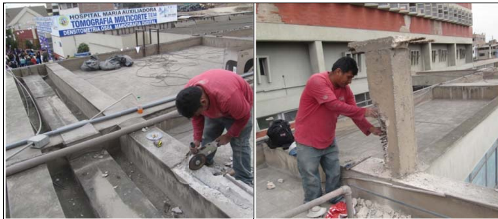
Foto 2. Extracción de muestras de acero y resane del concreto de la zona intervenida
