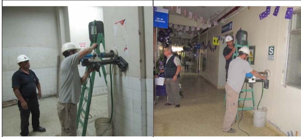
Foto 1. Extracción de núcleos de concreto
