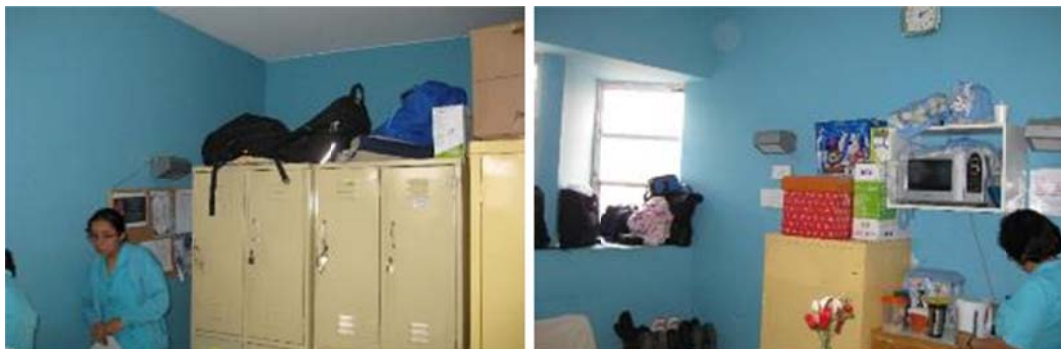
Figura 112: En el bloque C los casilleros no fijados a la pared, piso o techo, tienden al volcamiento en casos eventuales. Otro factor, es el desplazamiento de objetos ubicados en la parte superior de éstos. Microondas no sujetado, solamente colocado.
