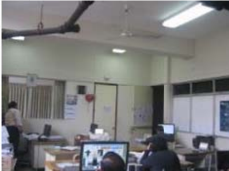
Figura 103: En el bloque C la mayoría de los casos, las computadoras, monitores e impresoras no están asegurados a los muebles, estos se encuentran únicamente colocados encima de los muebles de cómputo, asimismo, las estanterías tienen contenido apilados que no están debidamente asegurados, presenta riesgo de caída ante movimientos sísmicos.
