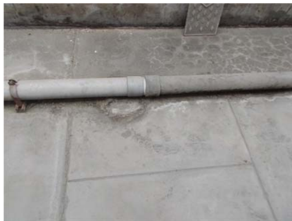
Figura 151. Tuberías reemplazadas por deterioro
