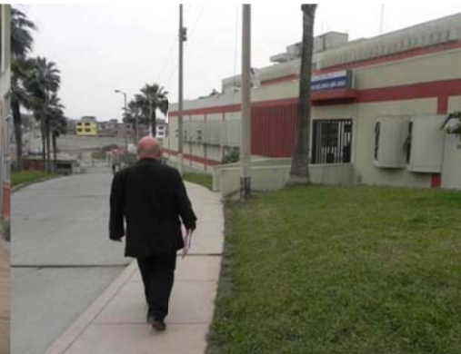
Figura 22. Ingreso natural al Servicio de Emergencia por la Av. Pachacútec, diseñado para ingreso de vehículos
