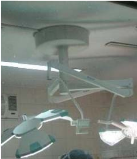
Figura 148: Izquierda: En el bloque C en Centro Quirúrgico (Entrepiso) los equipos médicos están fijados al techo, manteniéndolos suspendidos. (se debe verificar adecuada sujeción) Derecha: En el bloque K en Rayos X(Primer Piso) los equipos médicos están fijados al techo y a la pared.
