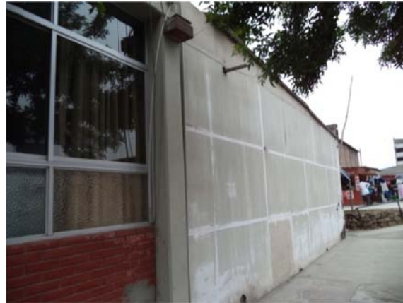
Figura 4. Construcción temporal a base de paneles.
