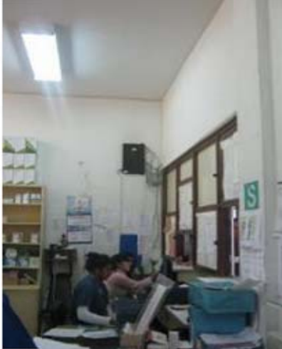
Figura 105: Izquierda: En el bloque J los equipos y estantes no están fijados. Derecha: en el bloque J en el almacén de farmacia los contenidos de las estanterías no están asegurados a techos o paredes, y estas pueden caer ante un movimiento.
