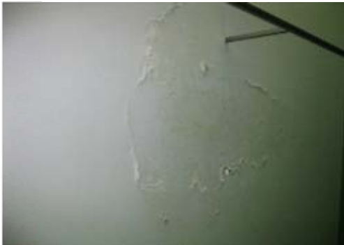
Figura 130: En el bloque C hay presencia de humedad en las paredes lo que provoca que la pintura se vaya saliendo y afectando la estructura. Derecha, muebles no fijados a muro con contenido en zona superior que puede caer en movimiento sísmico.
