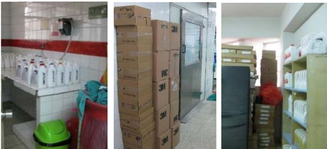
Figura 133: En el bloque C en la central de esterilización los insumos se encuentran colocados de manera inadecuada sobre el mobiliario con riesgo de desplazamiento ante cualquier eventualidad. Así como, las cajas de insumos apiladas contra la pared y con riesgo de volcamiento pudiendo evitar la circulación ante cualquier caso eventual.
