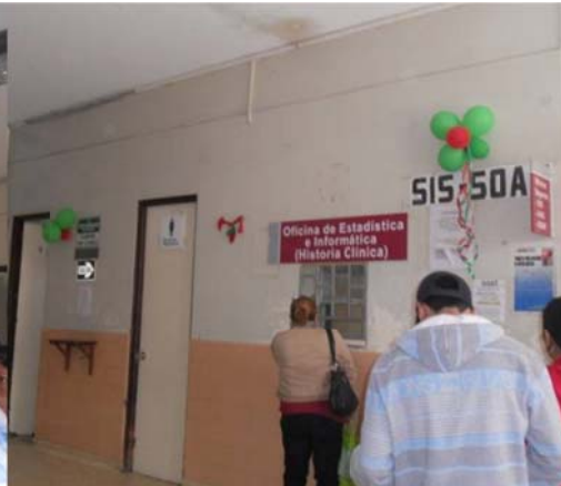
Figura 27. Área Administrativa al ingreso a emergencia, oficina de atención al SIS y al SOAT
