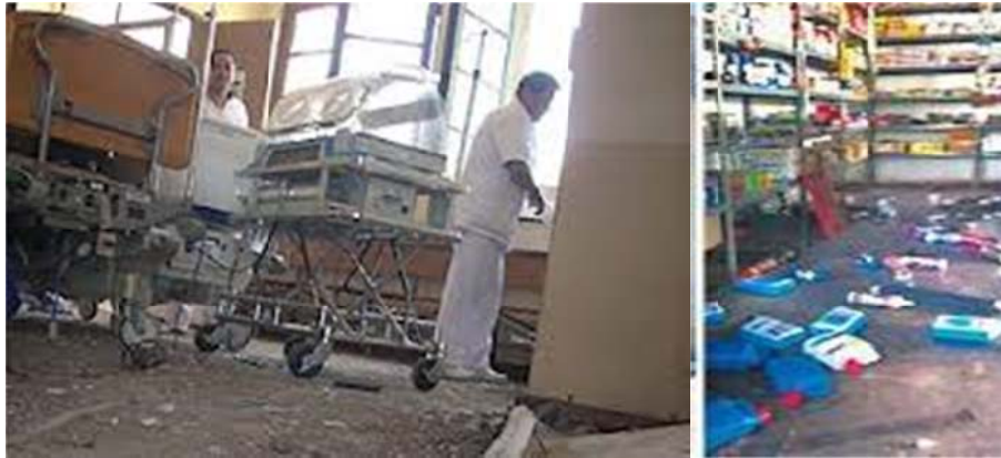
Figura 14 Desplazamiento de equipos que pueden ocasionar la inoperatividad de los mismos.
